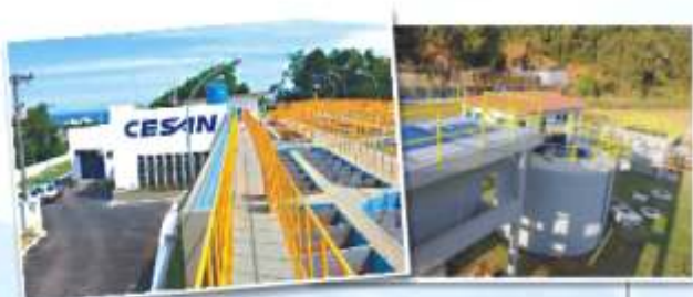
Estação de Tratamento de Água de Guarapari
