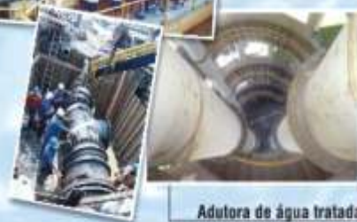
Adutora de água tratada para Vila Velha
