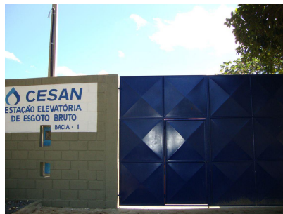
EEEB SOTECO MURO E PORTÃO
