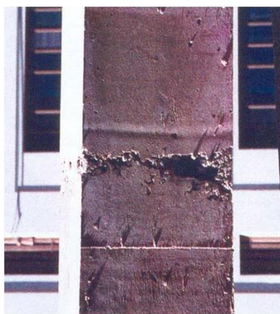
Material solto na superfície
