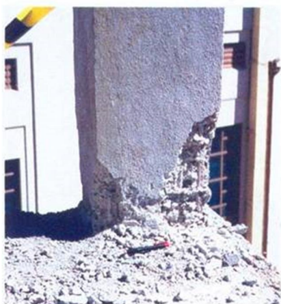
Vazio de concretagem
