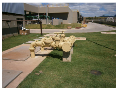
ETE OLARIA - GUARAPARI EEEB DE CLARIFICADO
