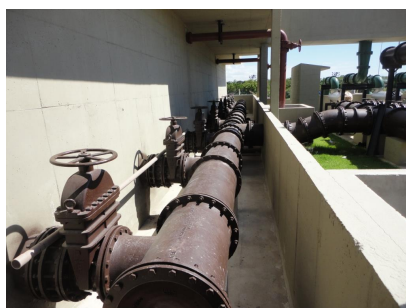
ETE OLARIA - GUARAPARI RETORNO DE LODO DECANTADO
