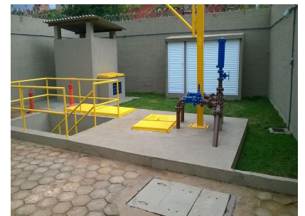
EEEB BOM JESUS DO NORTE VISTA INTERNA
