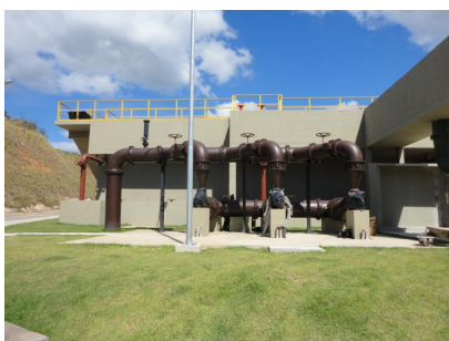
ETE OLARIA - GUARAPARI RETORNO DE LODO DECANTADO
