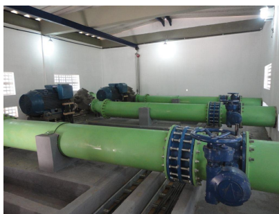
BOOSTER RIO GRANDE - GUARAPARI BARRILETE . ÁREA INTERNA
