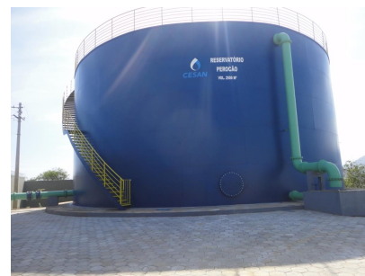
RESERVATÓRIO PEROCÃO - GUARAPARI VISTA GERAL
