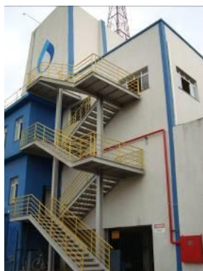
ETA COBI ESCADA METÁLICA
