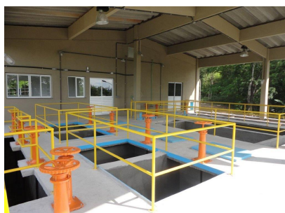
ETA VIANA FLOCULADOR, DECANTADORES E FILTROS
