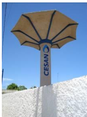
RESERVATÓRIO ELEVADO MUQUIÇABA GUARAPARI
