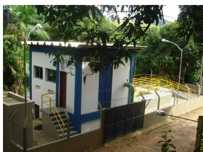
CAPTAÇÃO VIANA VISTA GERAL
