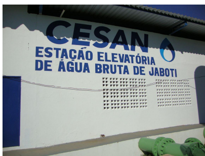
CAPTAÇÃO JABOTI - GUARAPARI EEAB - VISTA GERAL
