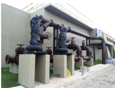
ETE OLARIA - GUARAPARI ELEVATÓRIA DE RECIRCULAÇÃO
