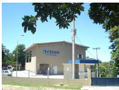
ETA VIANA VISTA GERAL
