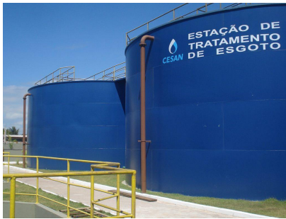
ETE ULISSES GUIMARÃES VISTA GERAL
