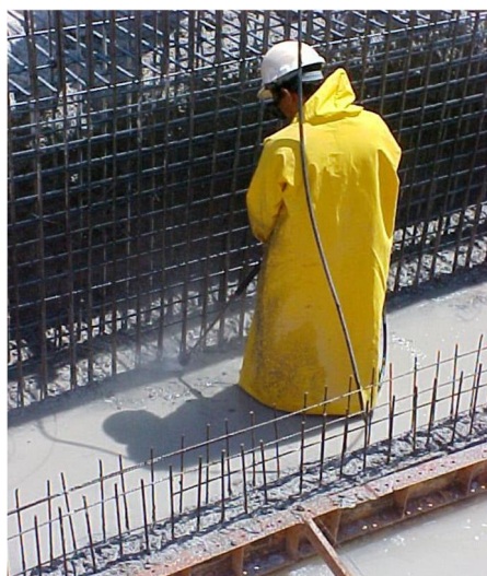
Escarificação, limpeza, colocação do espaçador e selante expansivo
