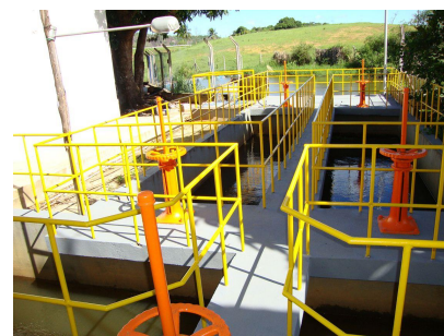
CAPTAÇÃO JABOTI - GUARAPARI CANAL E POÇO DE SUÇÃO
