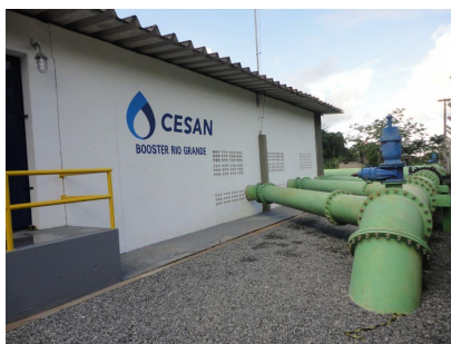
BOOSTER RIO GRANDE - GUARAPARI BARRILETE . ÁREA EXTERNA
