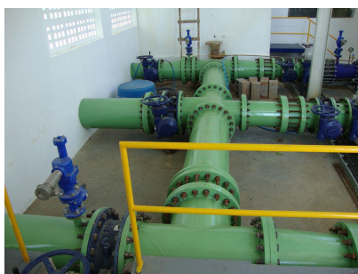
CAPTAÇÃO JABOTI - GUARAPARI EEAB - BARRILETE
