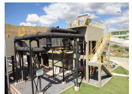
ETE OLARIA - GUARAPARI VISTA TRATAMENTO PRELIMINAR
