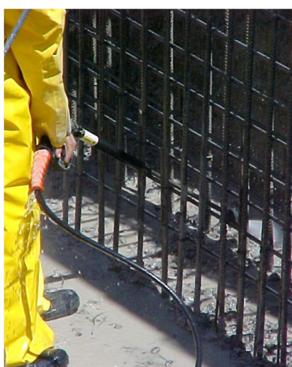
Escarificação, limpeza, colocação do espaçador e selante expansivo
