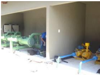
ETE ULISSES GUIMARÃES SOPRADORES E ULTRAVIOLETA
