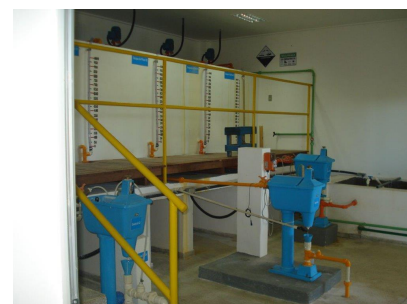
ETA VIANA SALA DE DOSAGEM
