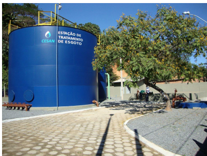
ETE SOTECO VISTA GERAL
