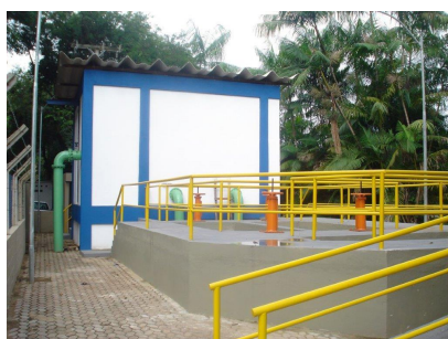
CAPTAÇÃO VIANA CANAL E POÇO DE SUCÇÃO
