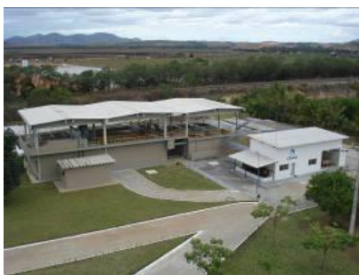
ETA SANTA MARIA VISTA GERAL
