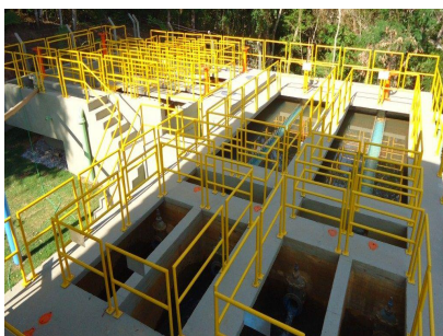
ETA IBATIBA FLOCULADOR, DECANTADORES E FILTROS
