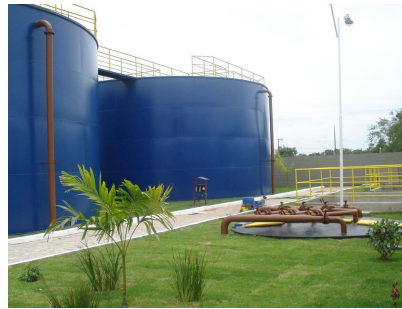
ETE ULISSES GUIMARÃES TRATAMENTO PRELIMINAR E EEEB
