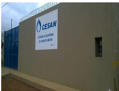
EEEB BOM JESUS DO NORTE MURO E PORTÃO
