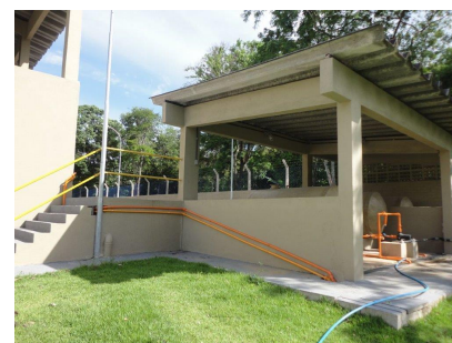
ETA VIANA ABRIGO DE PRODUTOS QUÍMICOS
