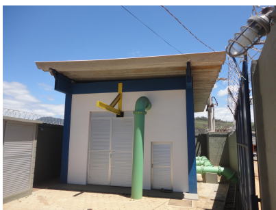
BOOSTER PEROCÃO - GUARAPARI VISTA INTERNA DA ÁREA
