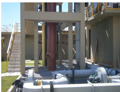
ETE OLARIA - GUARAPARI CLARIFICADO / DESCARGA / GÁS
