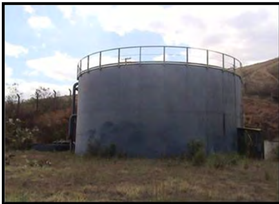
FOTO 17 - ÁREA DA ETE EXISTENTE E DA ÁREA DA AMPLIAÇÃO
