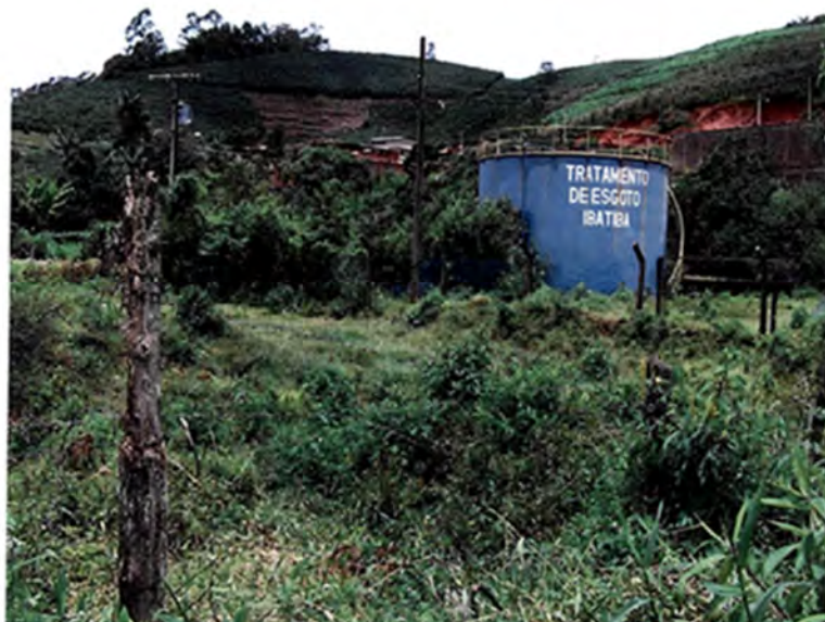
FOTO 24 – ETE EXISTENTE E ÁREA DA AMPLIAÇÃO
