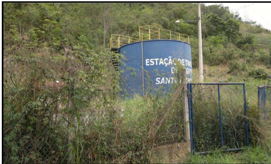
FOTO 36 - AREA DA ETE EXISTENTE E DE AMPLIAÇÃO
