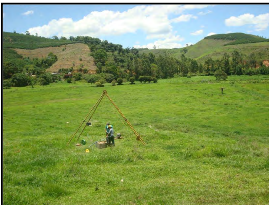
FOTO 4 - ÁREA DA ETE
