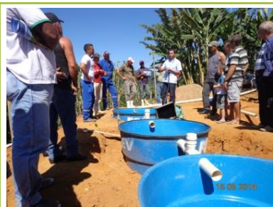
Figura 4.a – Mangaraí - Piloto de Fossa Biodigestora
