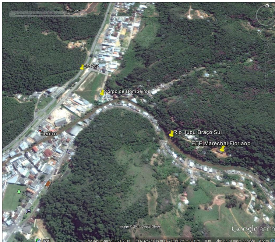
Figura 6: Localização da ETE Marechal Floriano
