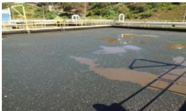
Figura 20: Início do tratamento: tanque anóxico (entrada submersa)
