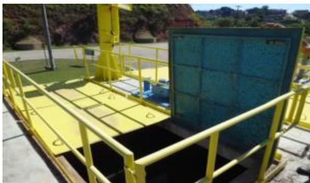
Figura 19: Tratamento preliminar: caixa de areia, desarenadores e rosca transportadora
