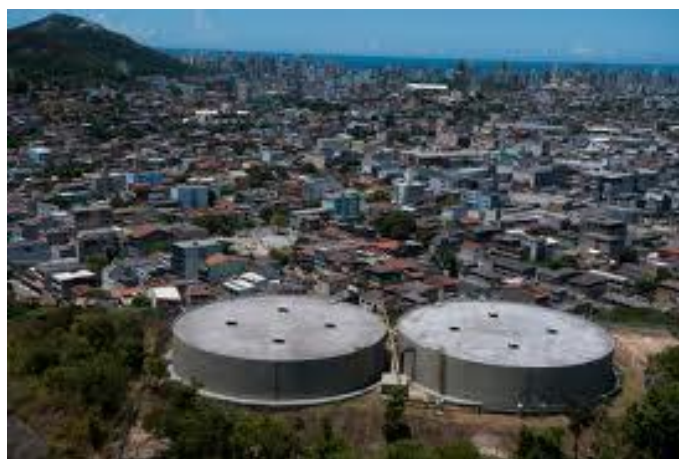
Reservatório de Água Tratada do bairro Garoto – Vila Velha.
