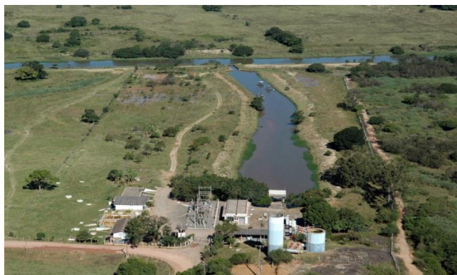
Captação de água bruta no Rio Jucu
