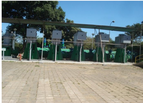
Estação Elevatória Baixo Recalque – Cariacica
