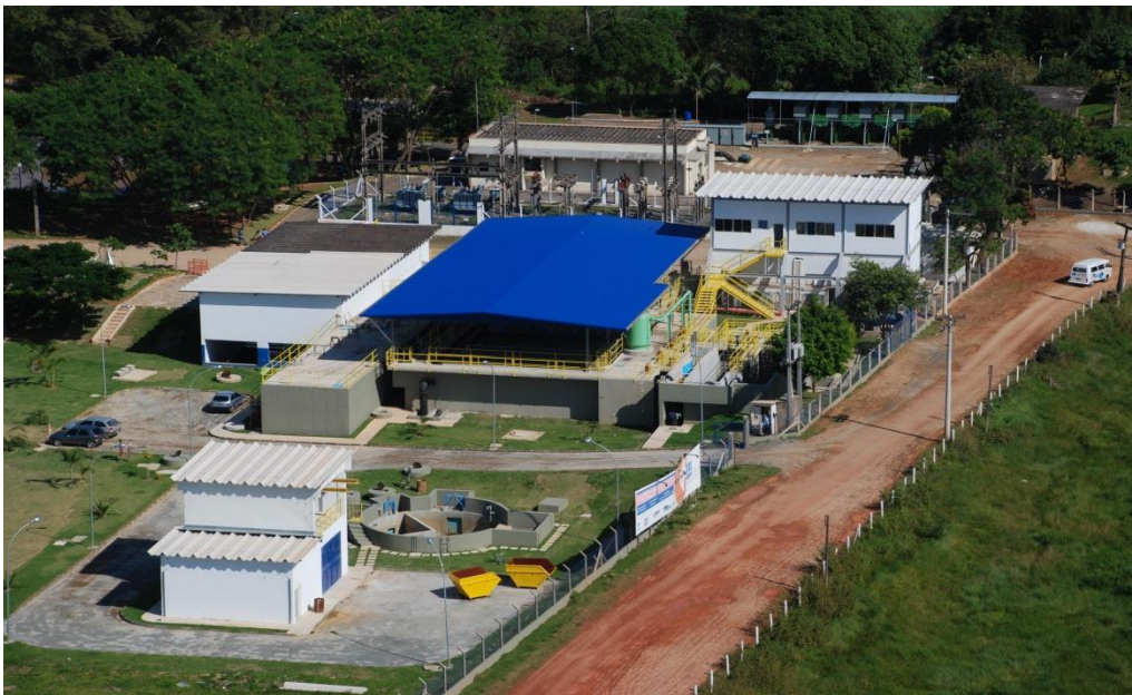
Estação de Tratamento de Água em Caçaroca – Vila Velha
