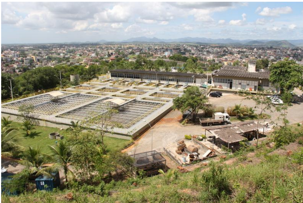
Estação de Tratamento de Água de Vale Esperança (ETA 1 – Cariacica)
