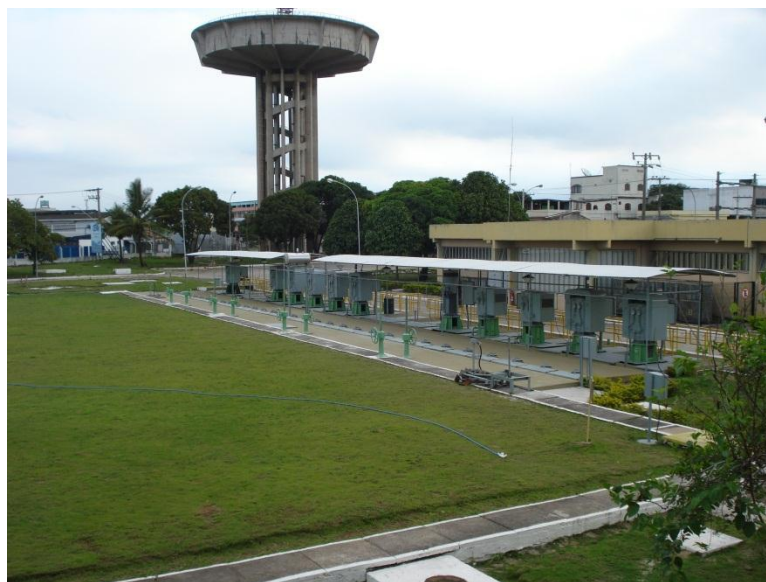
Estação Elevatória Planalto– Serra
