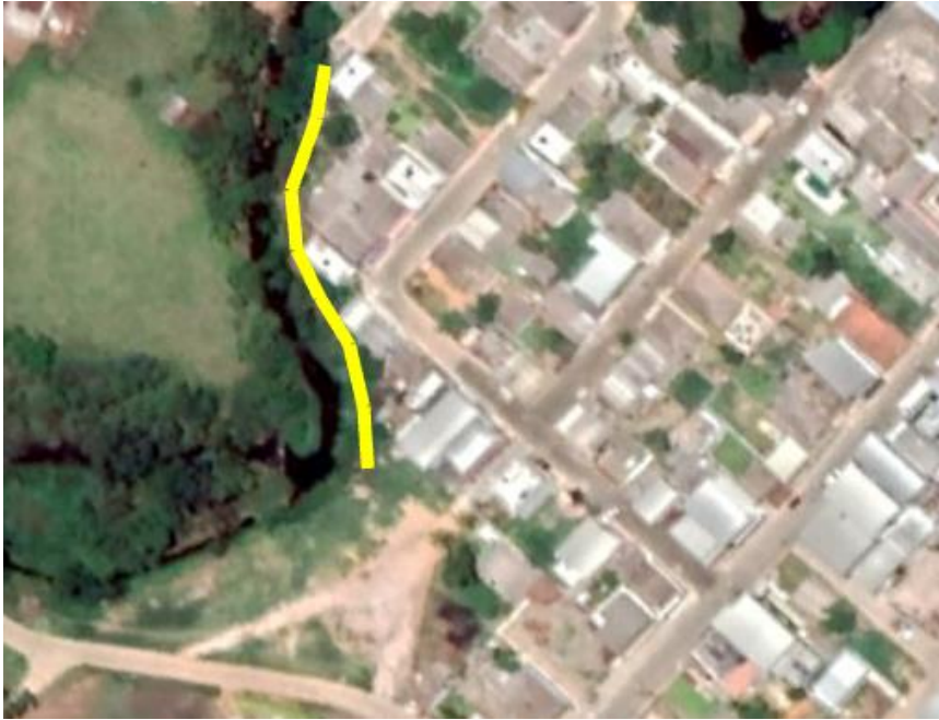
Figura 24 - Trecho 2: composta de 69 m de rede enterrada e 65 m de rede exposta.
