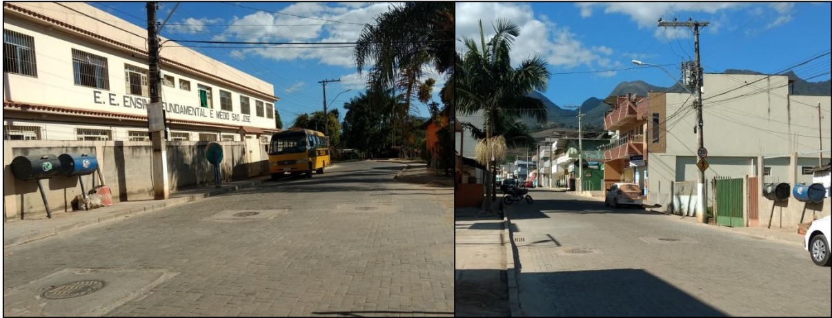
Figura 8 - Fotos da Rua Principal que dispõe de Rede Coletora Existente.
