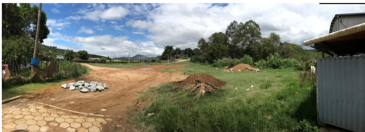
Figura 35 - Servidão chegada de tubulação de esgoto EEEB 1
