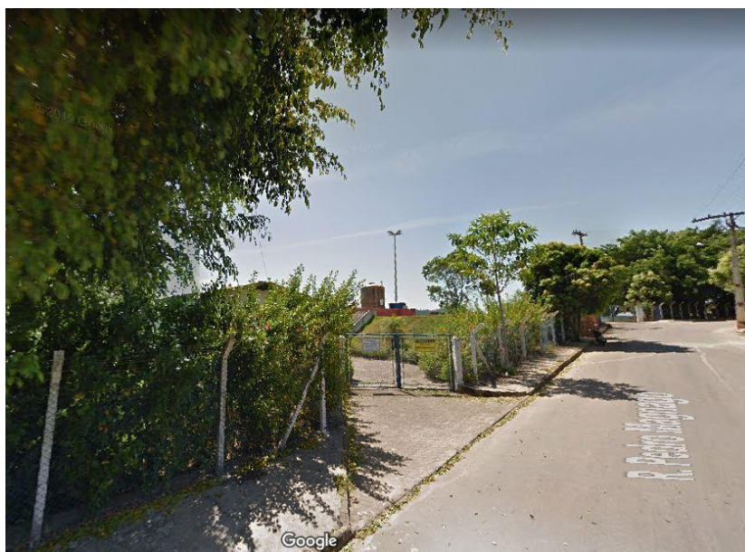
Figura 7 - Vista da Entrada da ETE Castelo.
