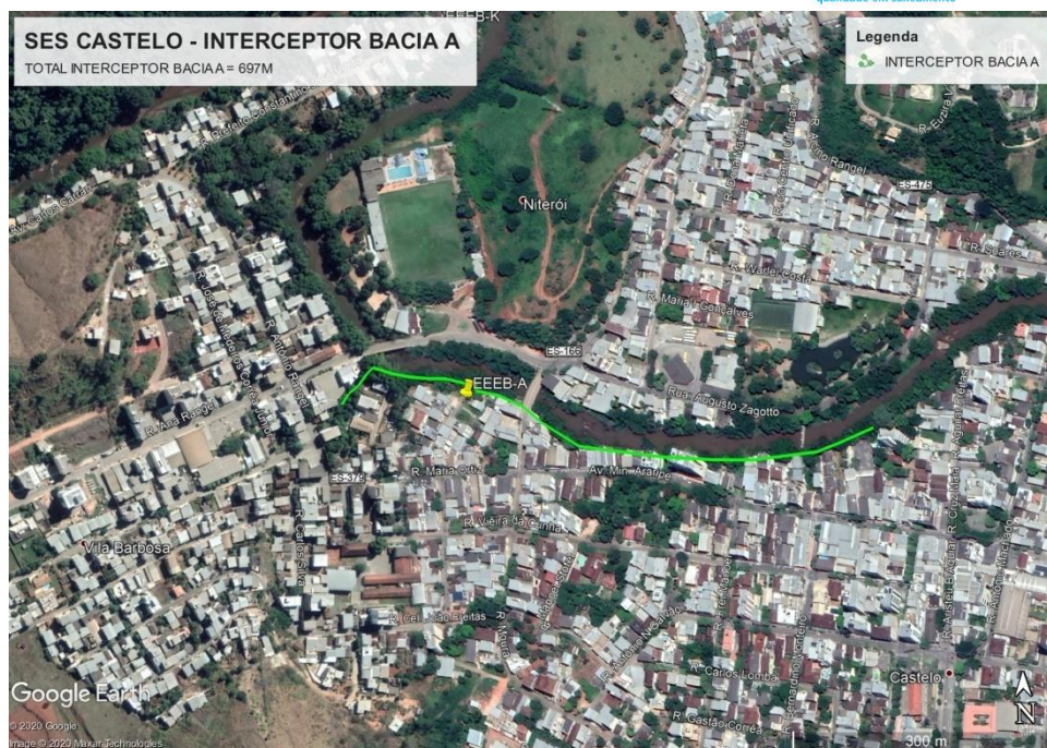
Figura 40 – Interceptora Bacia A - 650 m enterrado e 47 aéreo.
