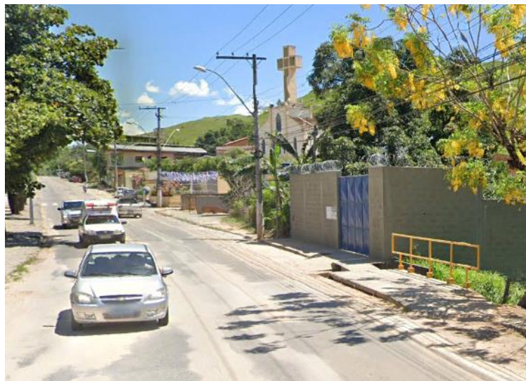
Figura 23 – Rua de acesso a EEEB-H.
