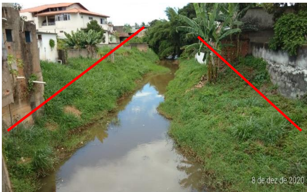
Figura 30 – Localização de trecho onde será instalada rede beira-rio.
