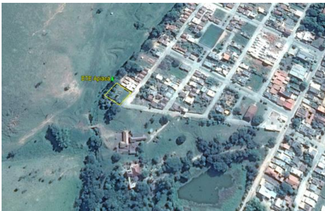
Figura 15 - Ocupação do entorno da ETE Apiacá.
