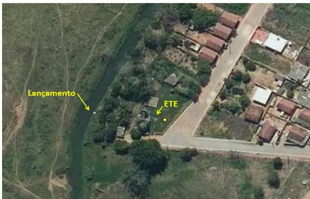
Figura 4 - Localização da ETE Apicá e do ponto de lançamento no Córrego Santa Bárbara.
