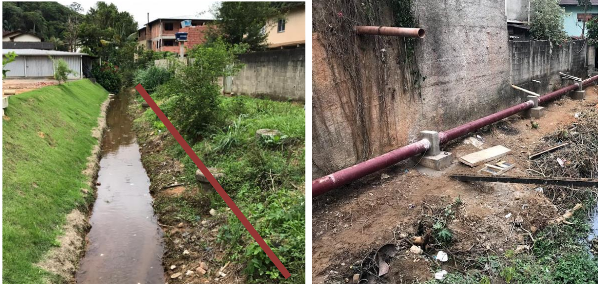
Figura 32 – Redes beira-rio já implantadas pela CESAN em outro empreendimento.
