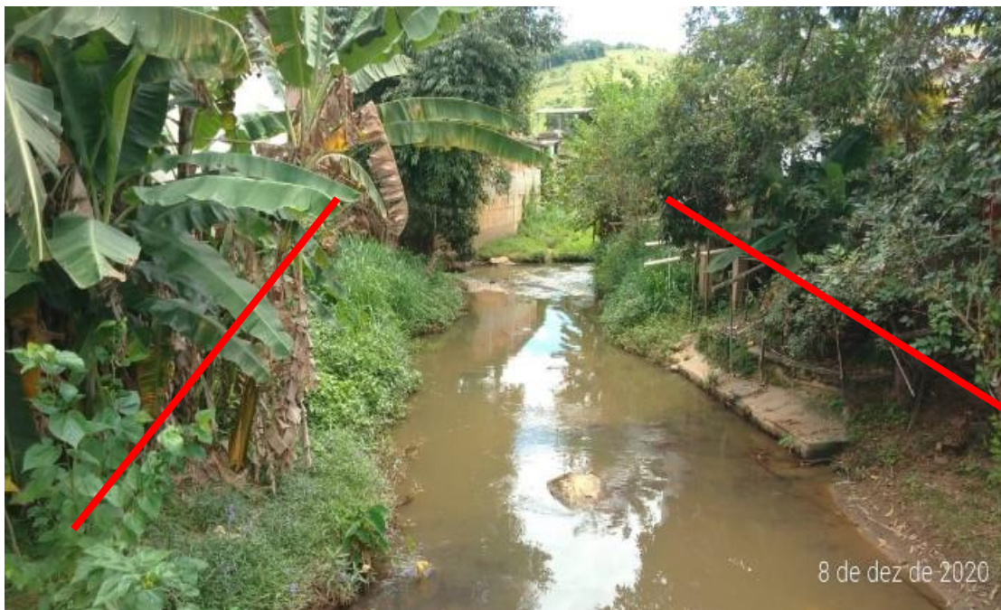
Figura 28 – Localização de trecho onde será instalada rede beira-rio.
