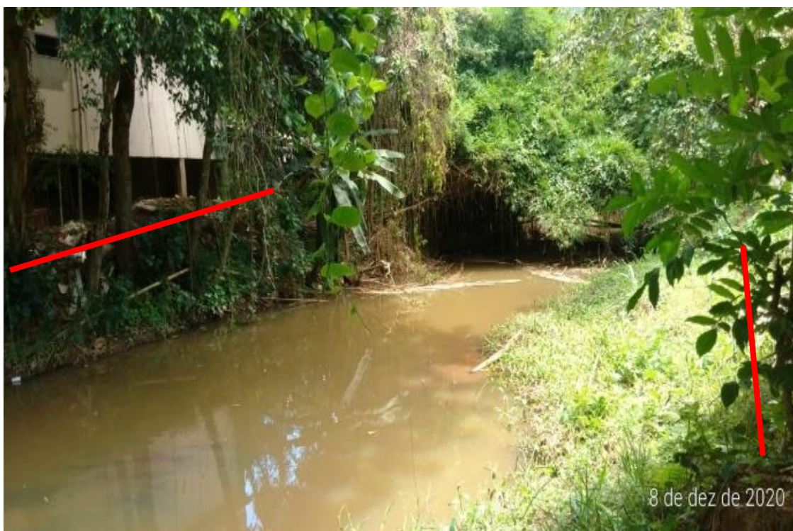
Figura 31 - Localização de trecho onde será instalada rede beira-rio.
