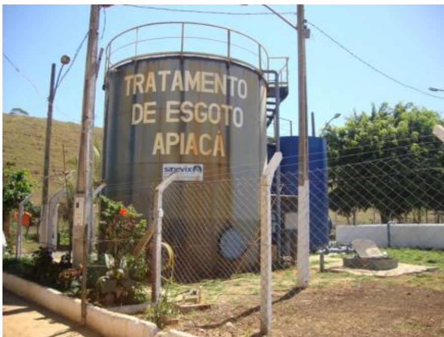
Figura 3 - Estação de Tratamento de Esgoto de Apicá.
