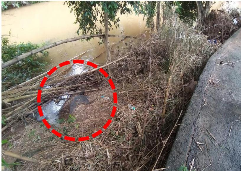
**Figura 9 - Extravasor para o Rio da EEEB-A inoperante que será reconstruída (Bacia A).**
