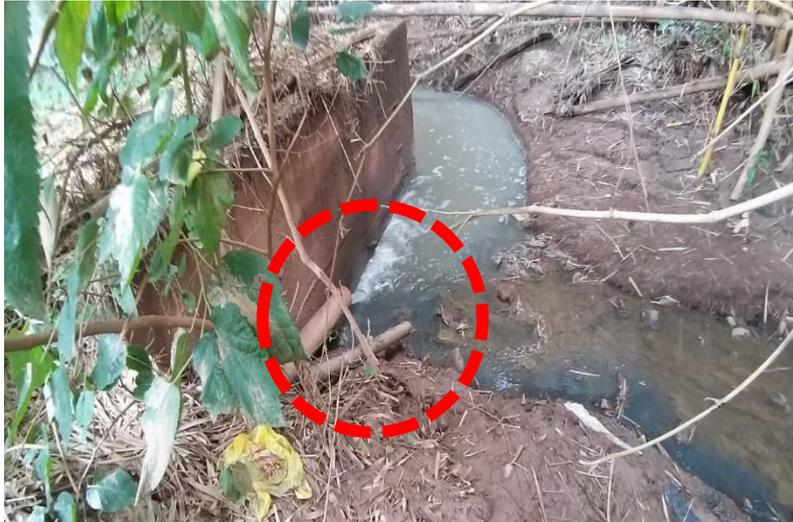
**Figura 8 - Extravasor para o Rio da ETE Volta Redonda que será desativada (Bacia A).**
