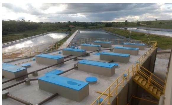
Estação de tratamento de esgoto de Pinheiros
