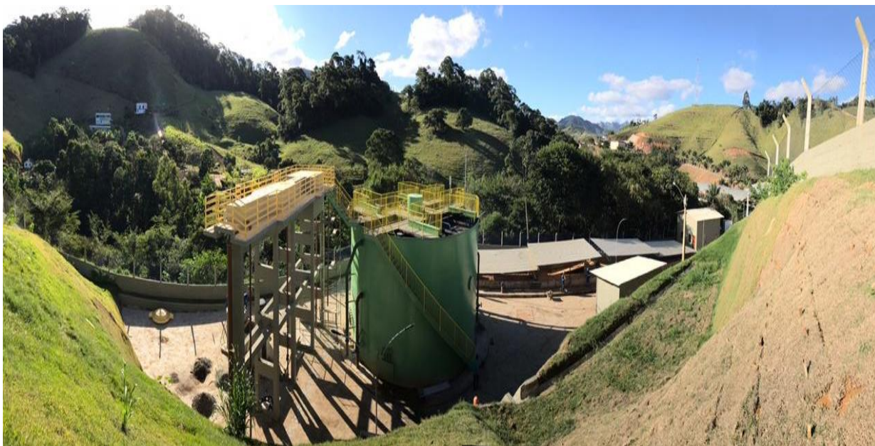
Estação de tratamento de esgoto de Conceição do Castelo
