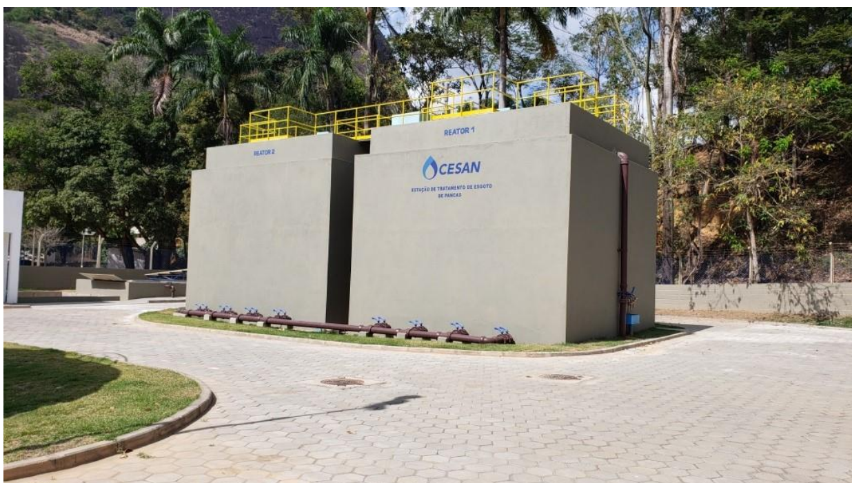
Estação de Tratamento de Esgoto de Pancas
