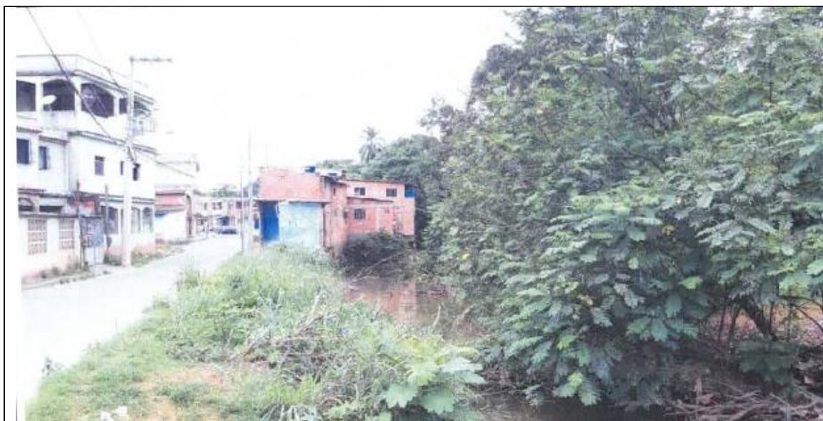
Foto 2: Vista para ocupação praticamente dentro do leito do córrego.
