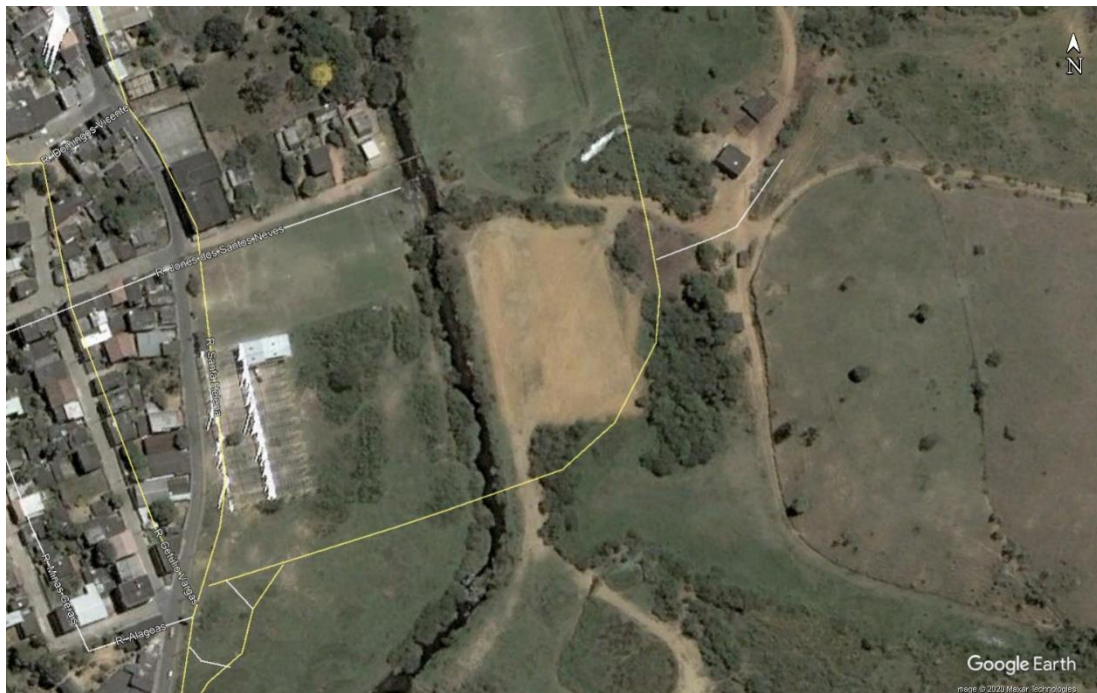
Figura 22 - Trecho 4 entre as estacas 36 + 5,05 m e 38 + 15,71 m, em 2007.
