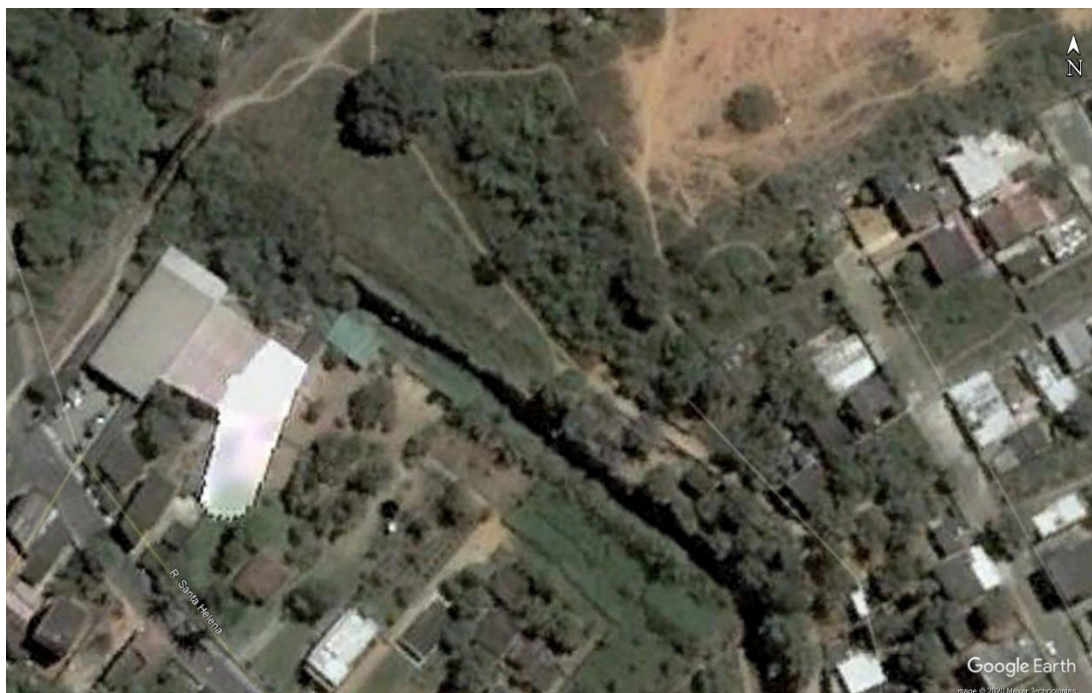
Figura 16 - Trecho 1 entre as estacas 0 e 5, em 2007.
