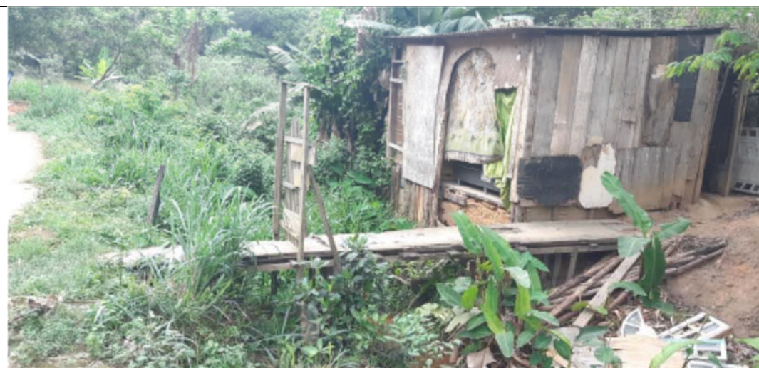
Foto 2: Sub- Bacia 08 – Vista para ocupação praticamente dentro do leito do córrego.
