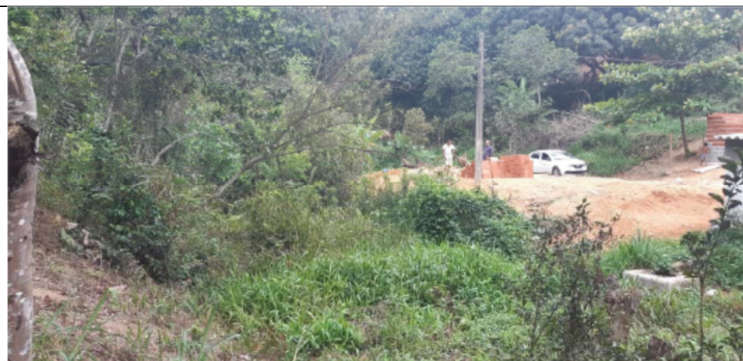
Foto 3: Sub-Bacia 08 – Construção de novas moradias ao longo do trecho em APP.
