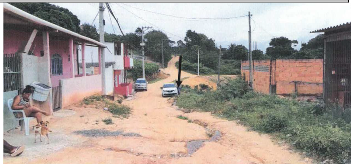
Foto 1: Sub-Bacia 18 - Trecho localizado em APP.
