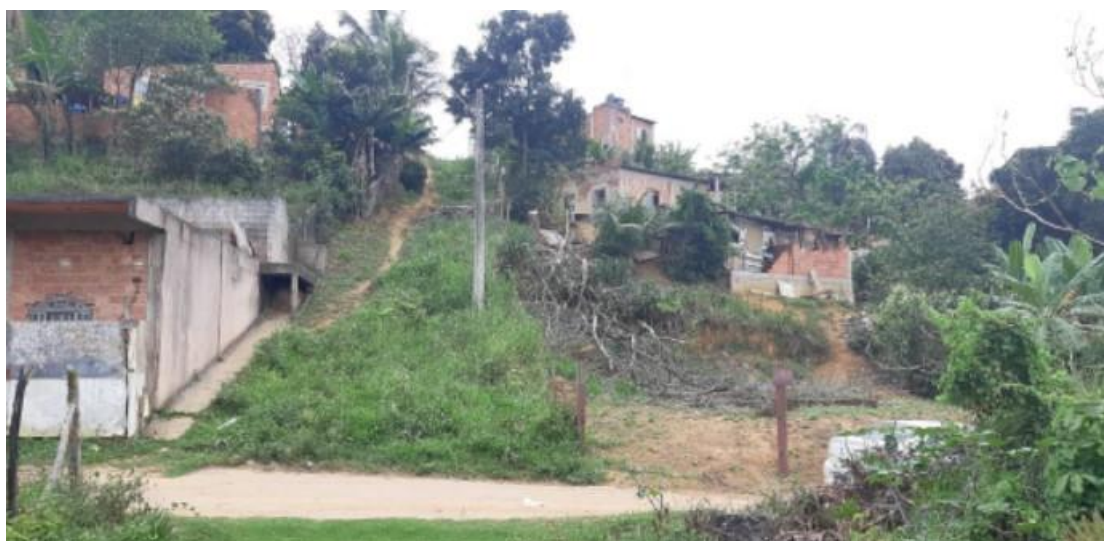
Foto 1: imóveis ocupando área de APP e entorno próximo.
