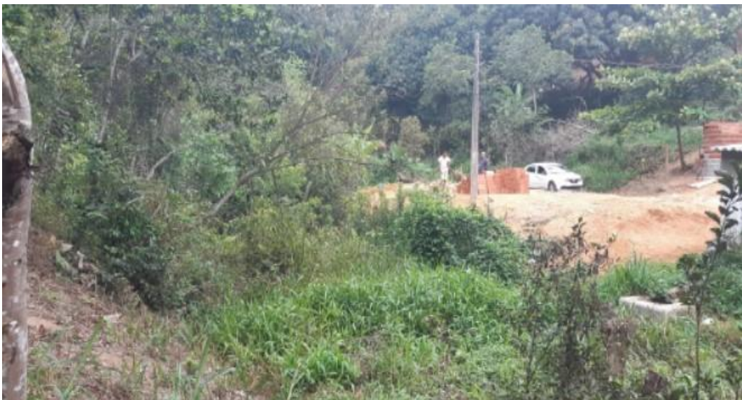
Foto 3: Construção de novas moradias ao longo do trecho em APP.
