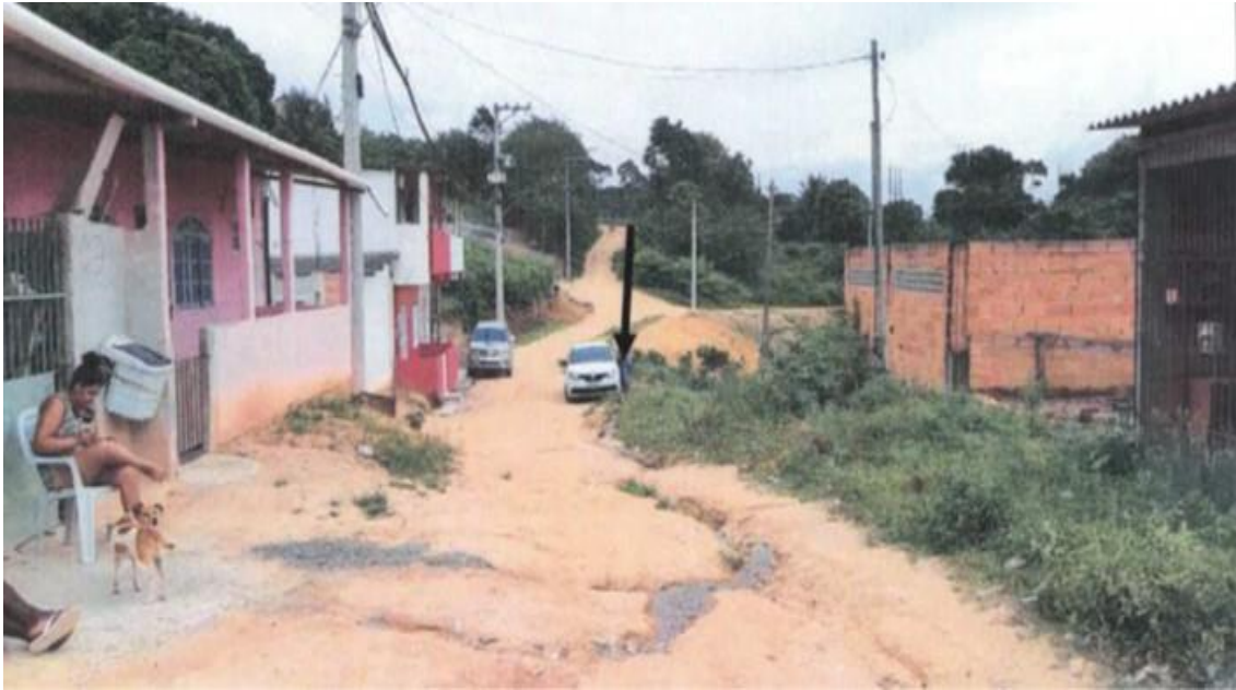
Foto 6: Trecho de expansão urbana localizado em APP.
