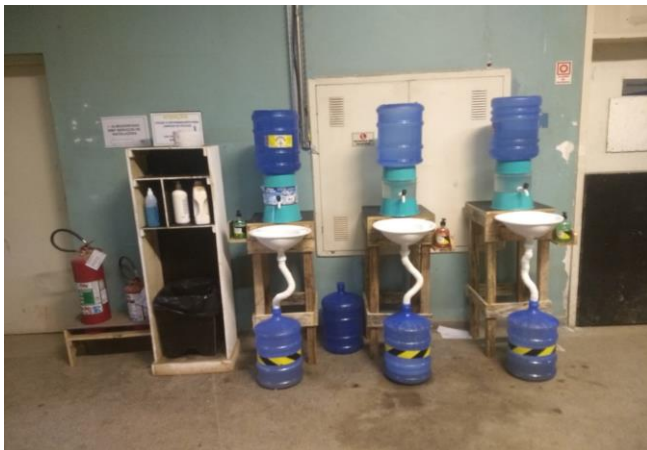
Lavatórios instalados na obra.
