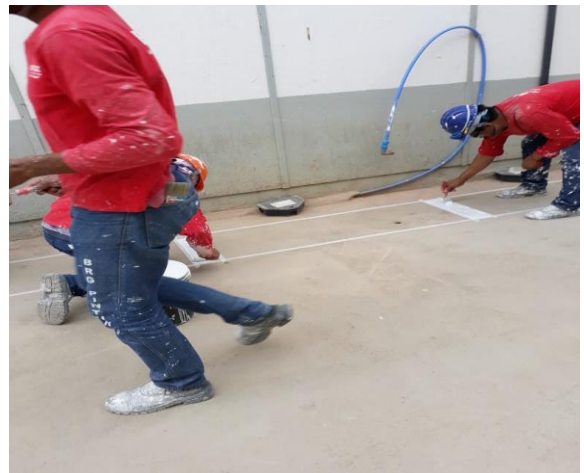
Marcação de piso – Unimed Vale do Sinos.
