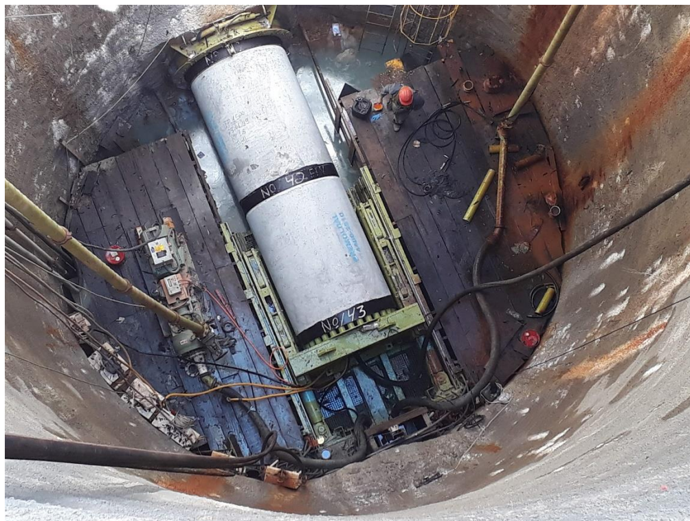
Figura 90 – Cravação de tudo pré-moldado a partir do poço de emboque.
