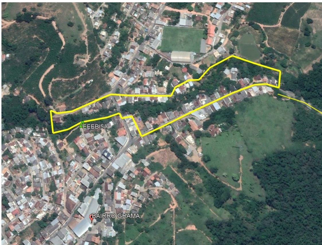
Figura 27 – Edificações da SB-5A que possuem caimento para o Rio.
