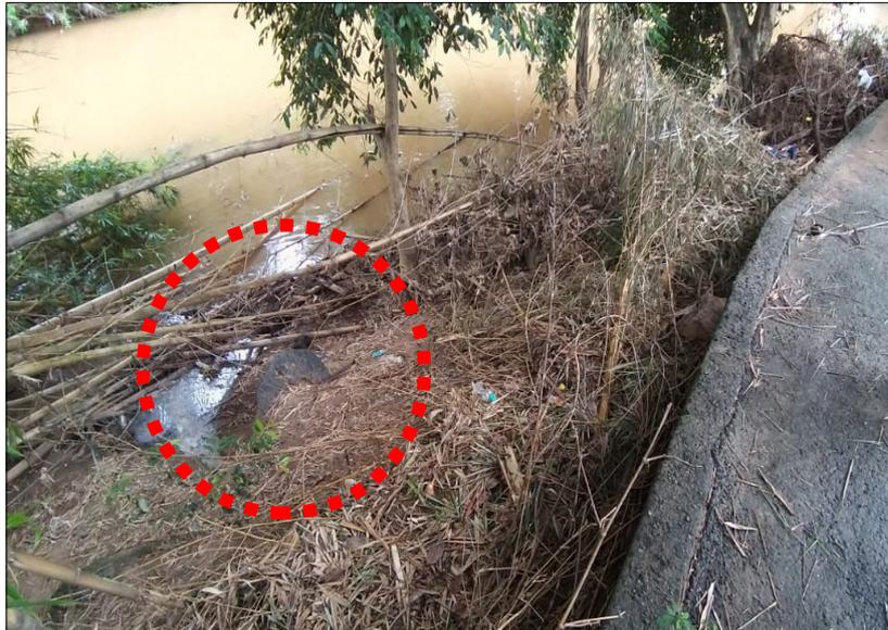
**Figura 9 - Extravasor para o Rio da EEBB-A inoperante que será reconstruída (Bacia A).**
