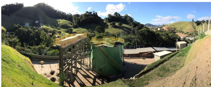
Estação de tratamento de esgoto de Conceição do Castelo
