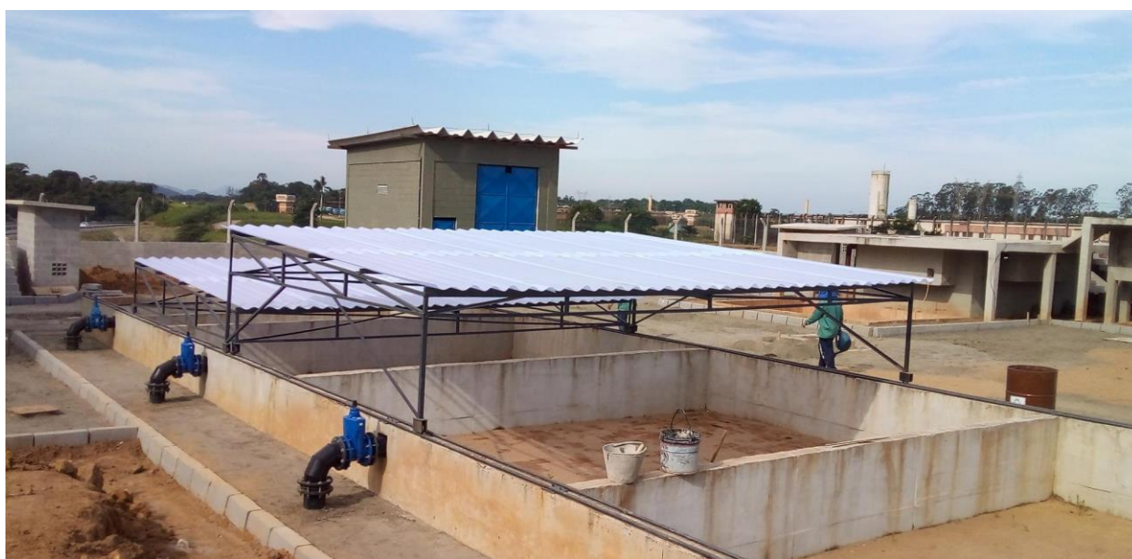
Estação de Tratamento de Esgoto de Xuri - Vila Velha - ES
