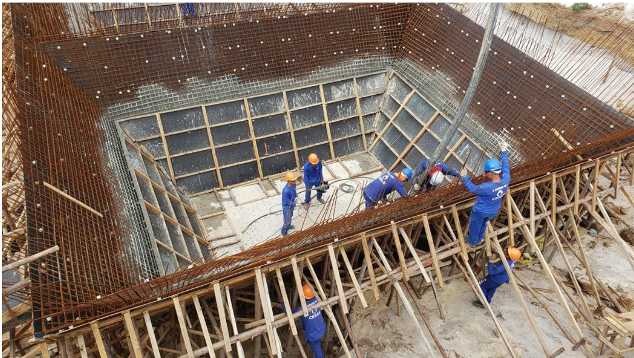
Estação de Tratamento de Esgoto de Anchieta - ES
