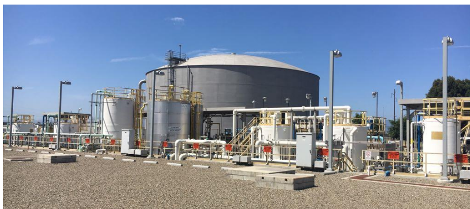
Foto da estação de água de reúso Silicon Valley - Califórnia - EUA
