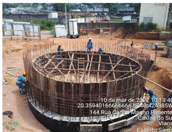
Execução da Elevatória de Esgoto Bruto de Caxias do Sul - Viana - ES
