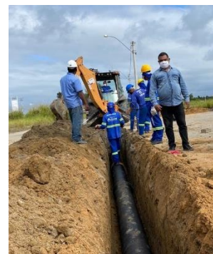
Adutora ETA V x Santa Cruz
