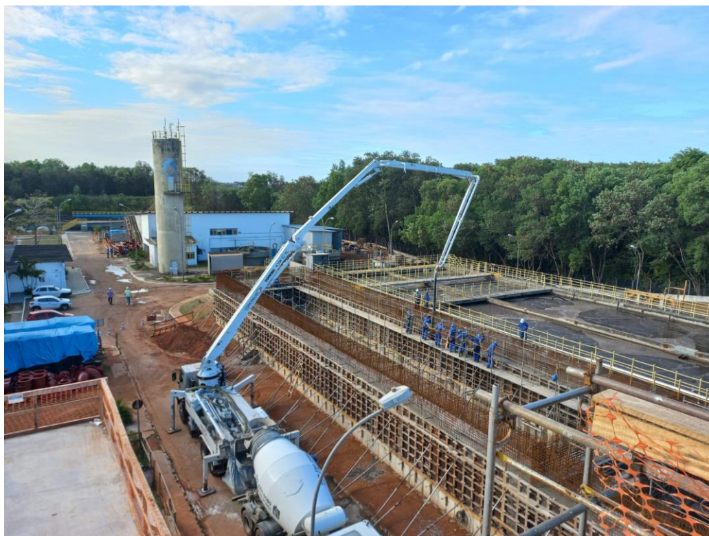
Obras de Duplicação da Estação de tratamento de Esgoto de Manguinhos
