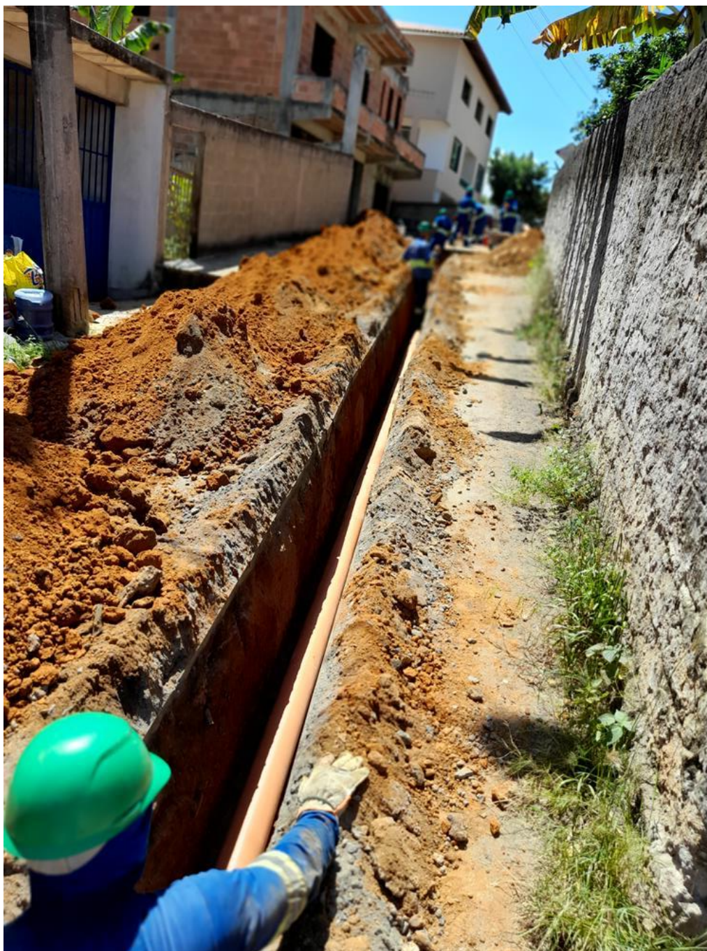
Ampliação do SES de Iriri - Anchieta - ES
