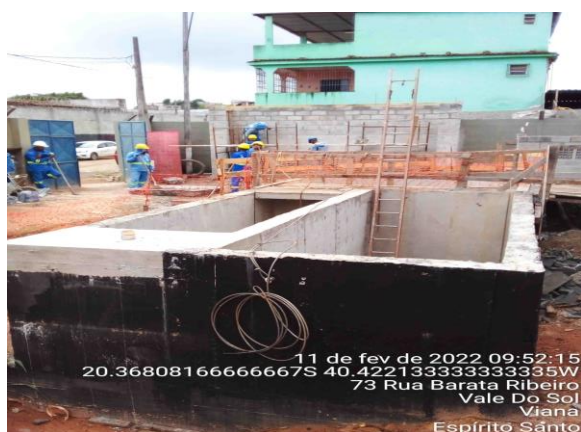
Execução do biofiltro e abrigo do quadro de comando da Elevatória de Esgoto Bruto de Soteco - Viana - ES
