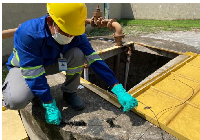
Estação Elevatória de Esgoto Bruto - Cariacica
