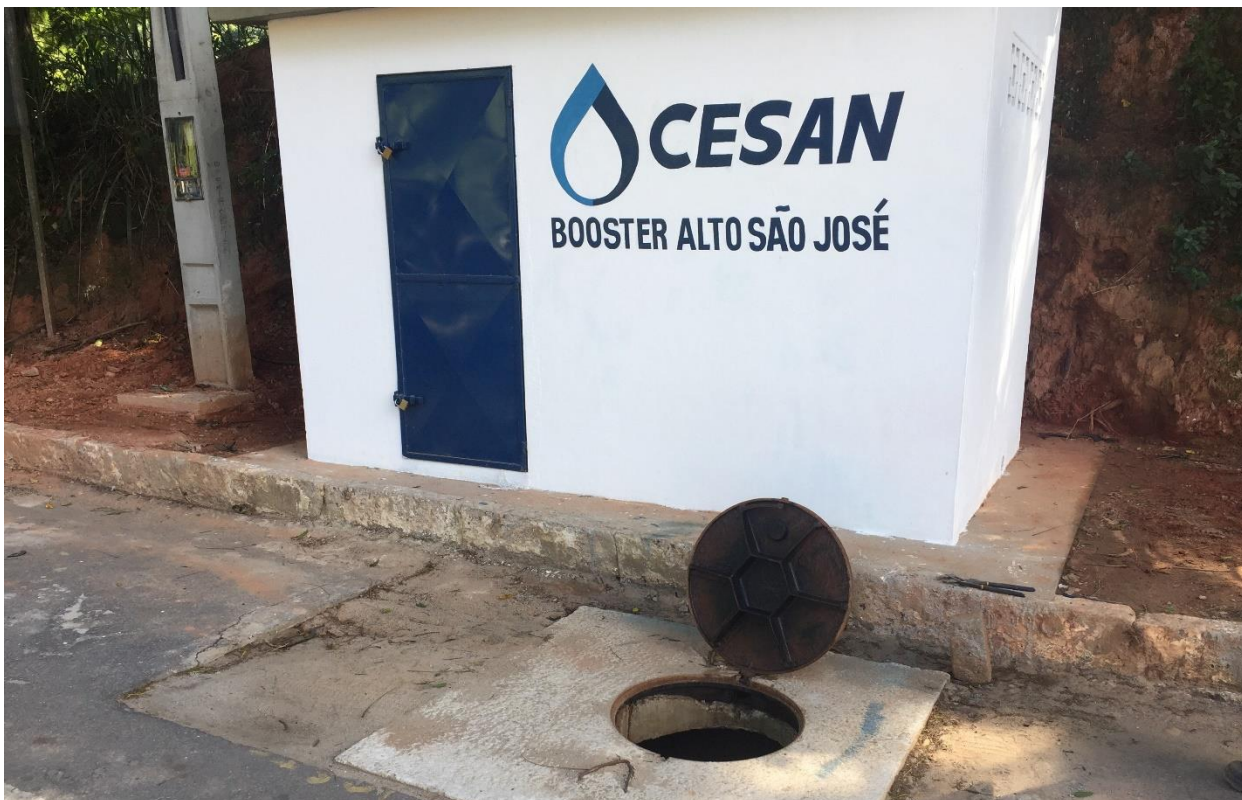
Ampliação do Abastecimento de Água de Alto São José - Atílio Vivacqua - ES
