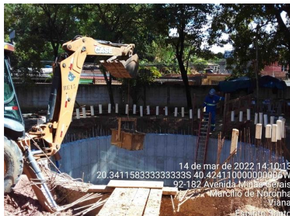
Construção da Elevatória de Esgoto Bruto de Marcílio de Noronha - Viana - ES
