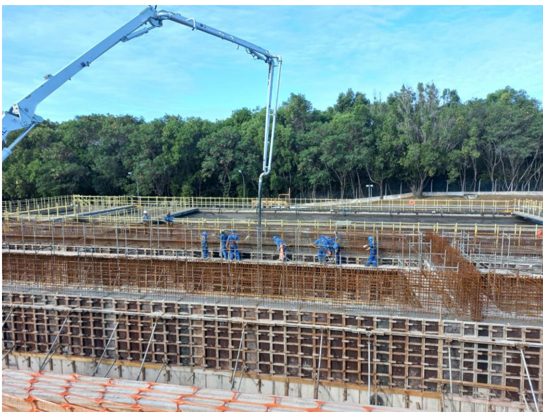
Obras de Duplicação da ETE Manguinhos
