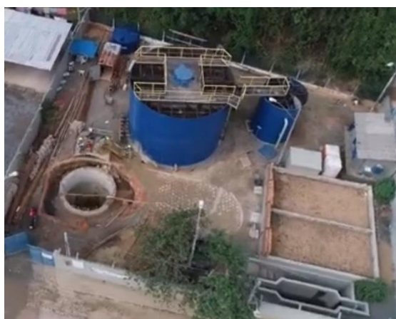
Execução do biofiltro e abrigo do quadro de comando da Elevatória de Esgoto Bruto de Soteco - Viana - ES
