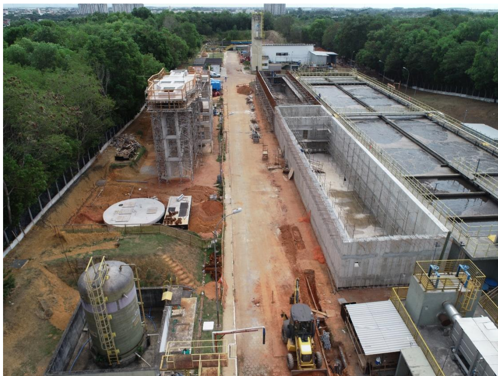
Estação de Tratamento de Manguinhos Serra - ES
