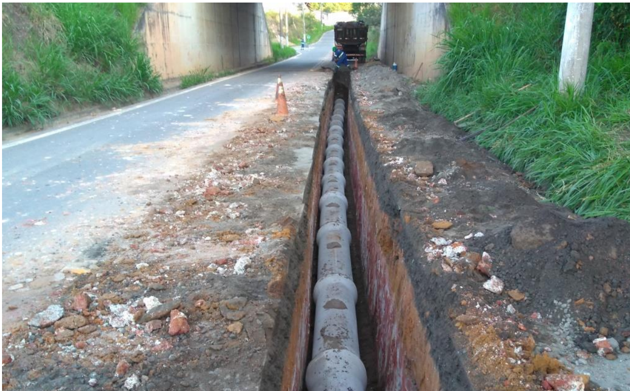
Ampliação do Abastecimento de Água de Jaboticaba e Andana - Guarapari - ES
