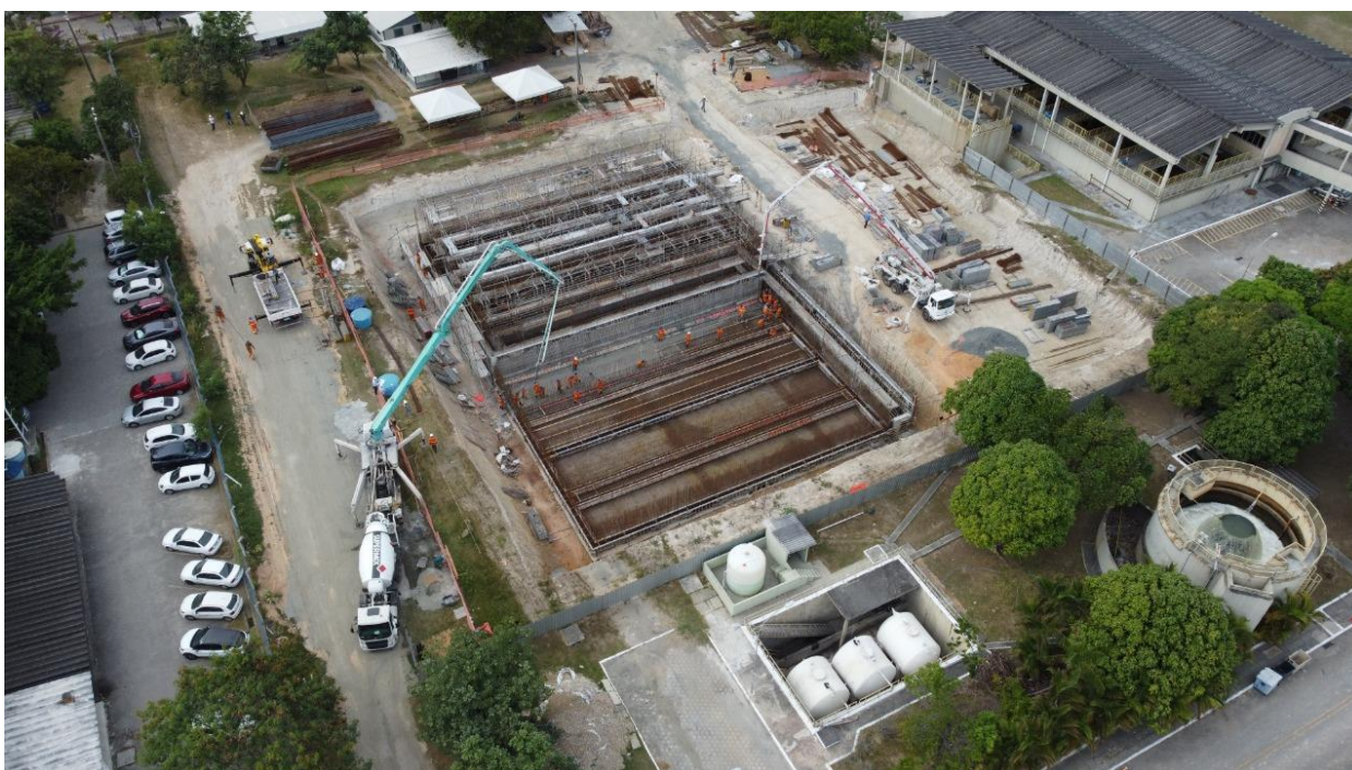
Obras de Melhorias e ampliação da ETA V - Carapina - Serra - ES
