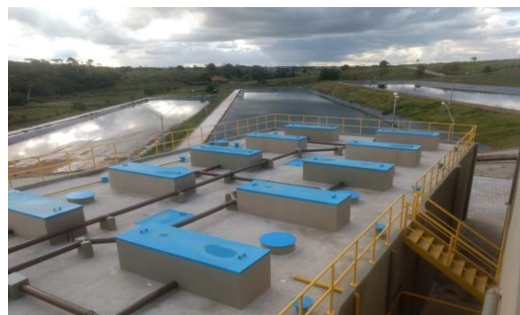
Estação de tratamento de esgoto de Pinheiros
