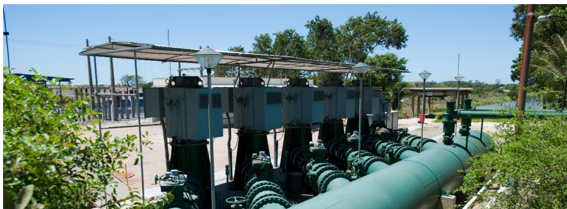
Estação de tratamento de água Caçaroca - Conjunto moto bomba baixo recalque
