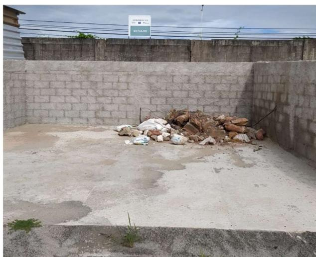
**Figura 15: Baia para o armazenamento de resíduos de alvenaria, concreto, areia, dentre outros.**
