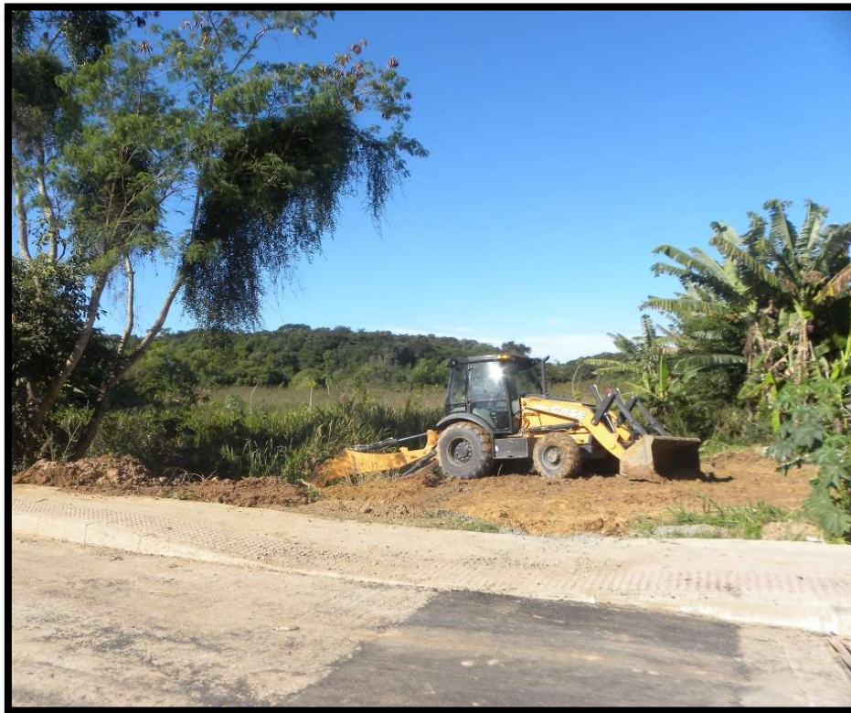
Registro 13 – Realização de Obras de drenagens realizadas pela Prefeitura de Vila Velha
