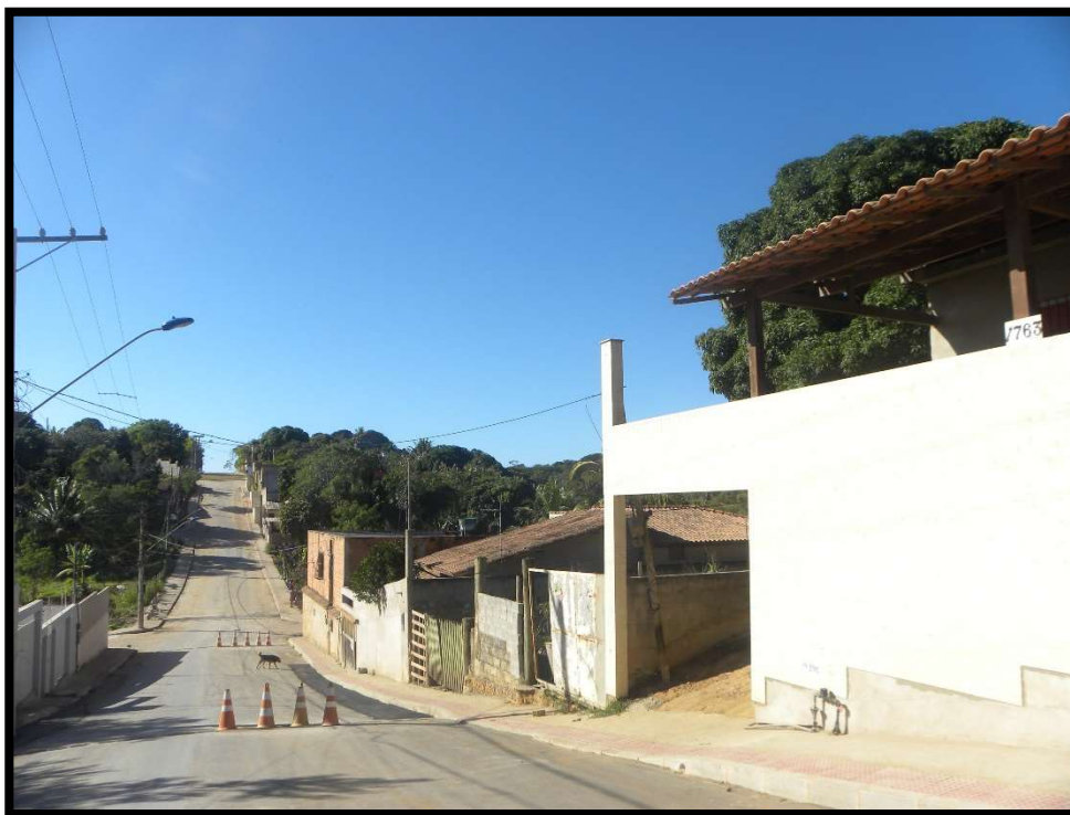
Registro 14 – Aspecto geral das ruas asfaltadas
