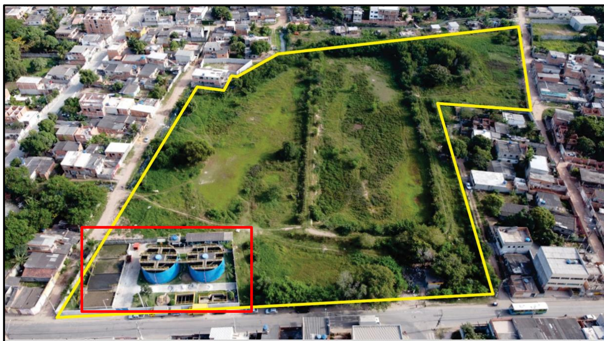
Figura 3 A figura ilustra a área da ETE, a qual demonstra o polígono de limitação do terreno em amarelo e a ETE existente dentro do polígono (retângulo em vermelho).
