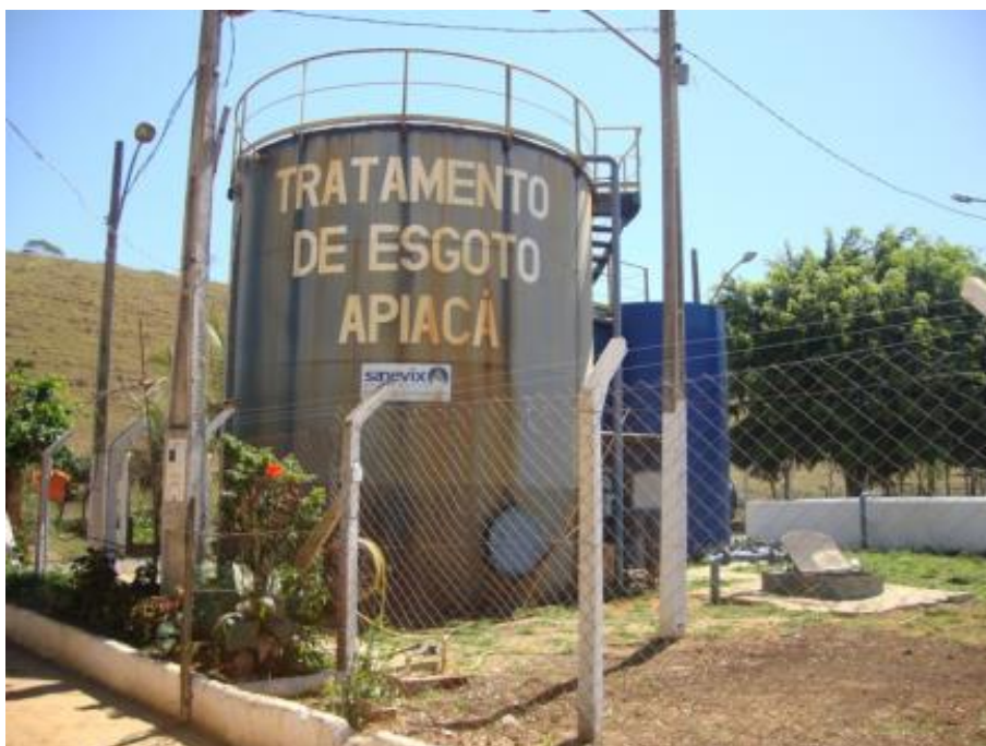
Figura 3 - Estação de Tratamento de Esgoto de Apicá.
