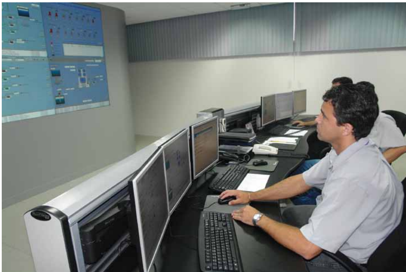
Centro de Controle Operacional da Cesan, em Carapina
