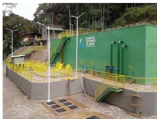
Estação de Tratamento de Esgoto – Marechal Floriano
