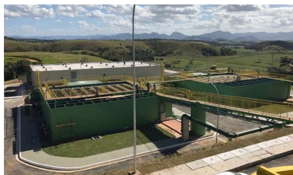
Estação de Tratamento de Água – Reis Magos
