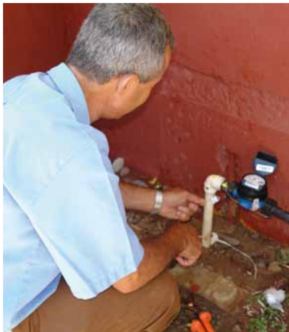
Fiscalização de hidrômetro
