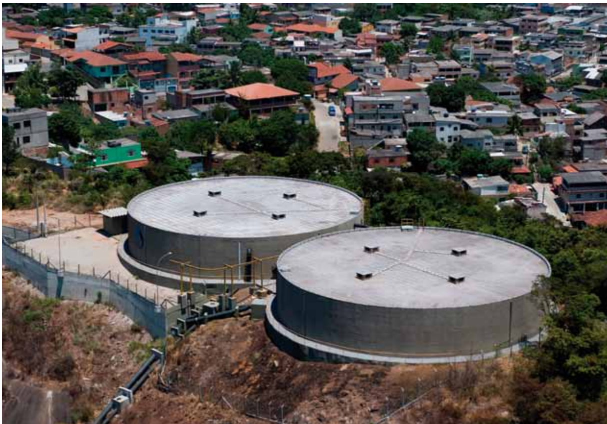
Reservatório de água Garoto, em Vila Velha, com capacidade para armazenar 16,5 milhões de litros de água
