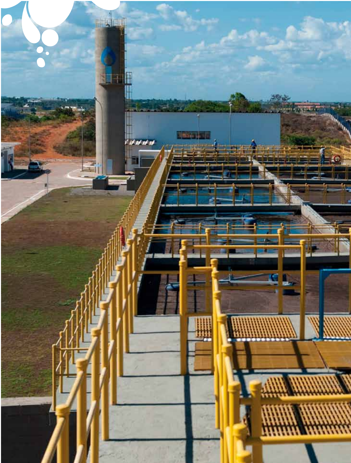
Estação de Tratamento de Esgoto Mangueiros, na Serra
