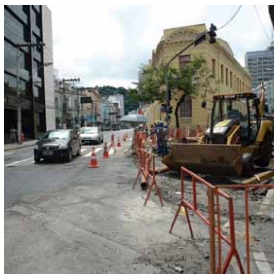
Obras de implantação de redes de esgoto no Centro de Vitória
