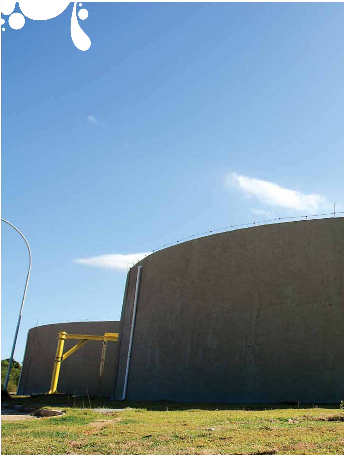
Reservatório de água Araçás, em Vila Velha, com capacidade para 6,5 milhões de litros
