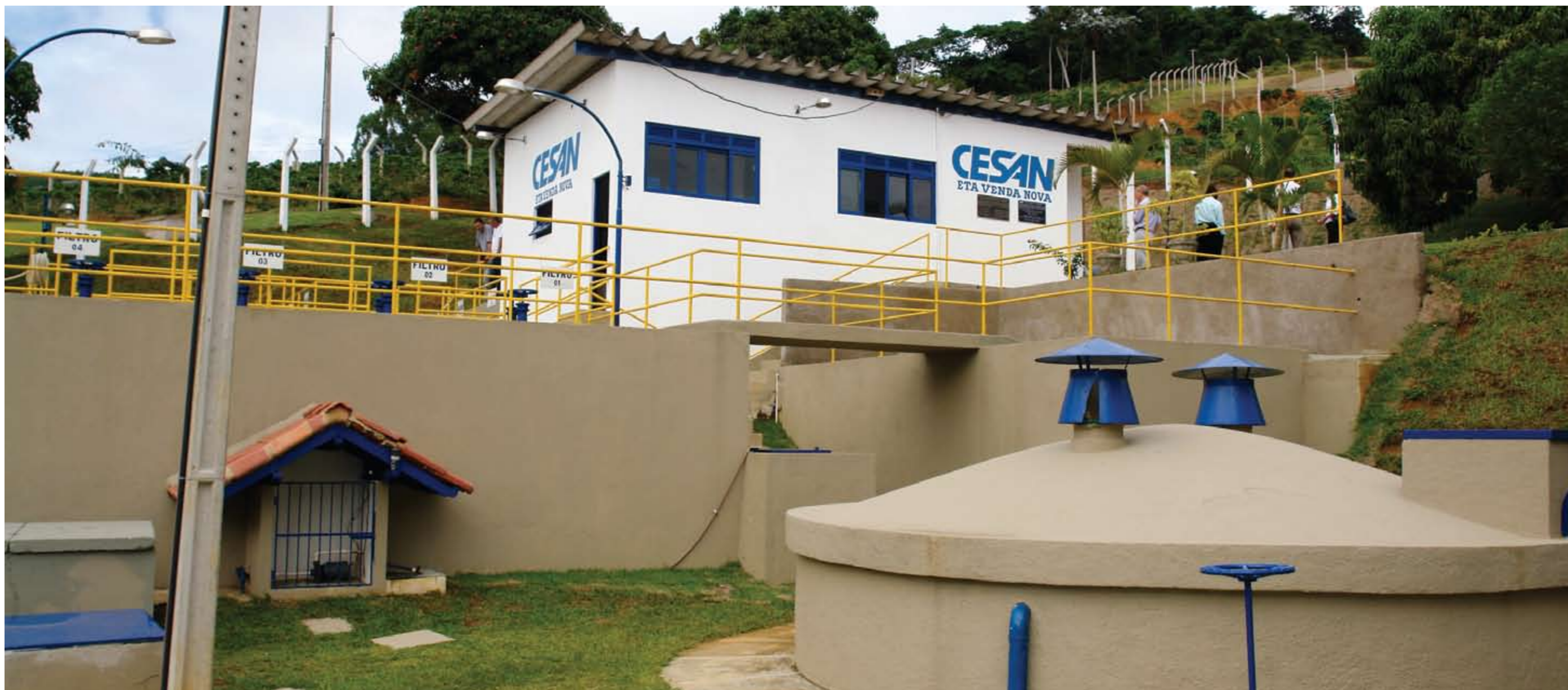
Estação de Tratamento de Água em Venda Nova do Imigrante
