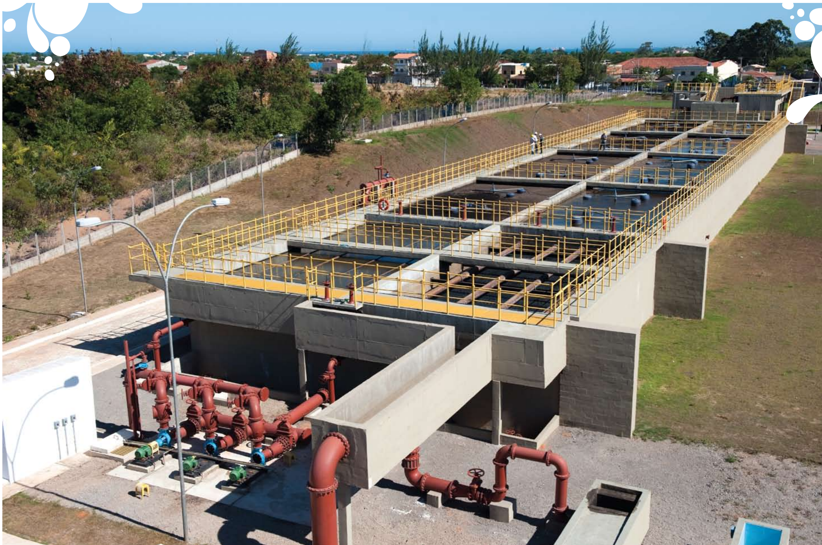
Estação de Tratamento de Esgoto Mangueiros, na Serra
