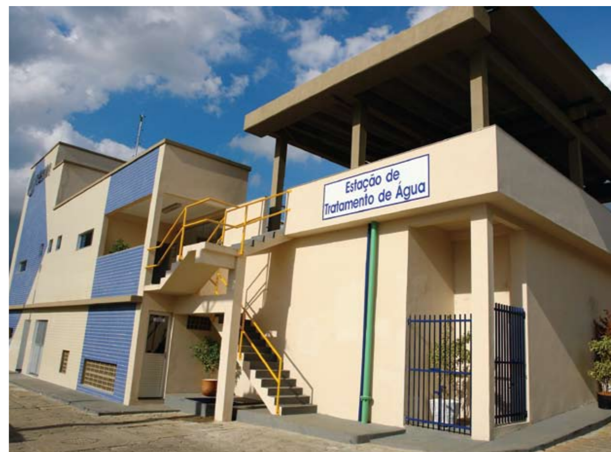
Estação de Tratamento de Água em Nova Venécia
