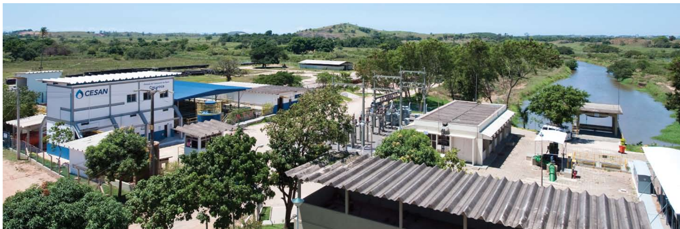
Estação de Tratamento de Água Caçaroca, em Cariacica
