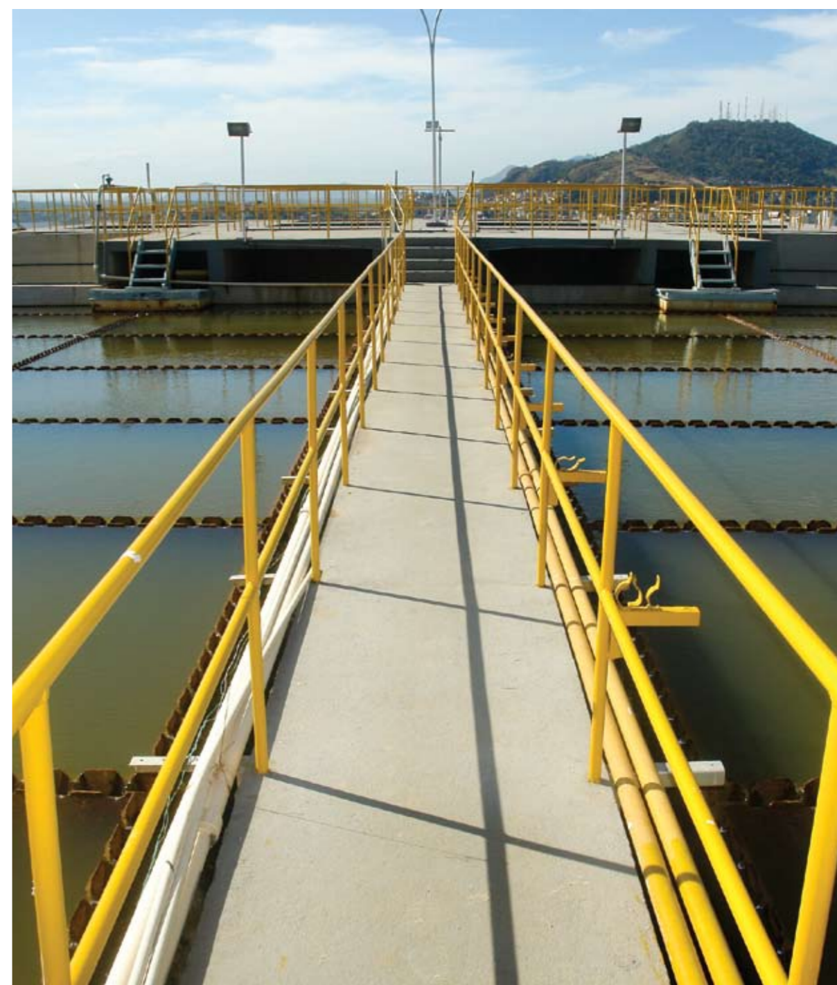
Estação de Tratamento de Água Cobi, em Vila Velha
