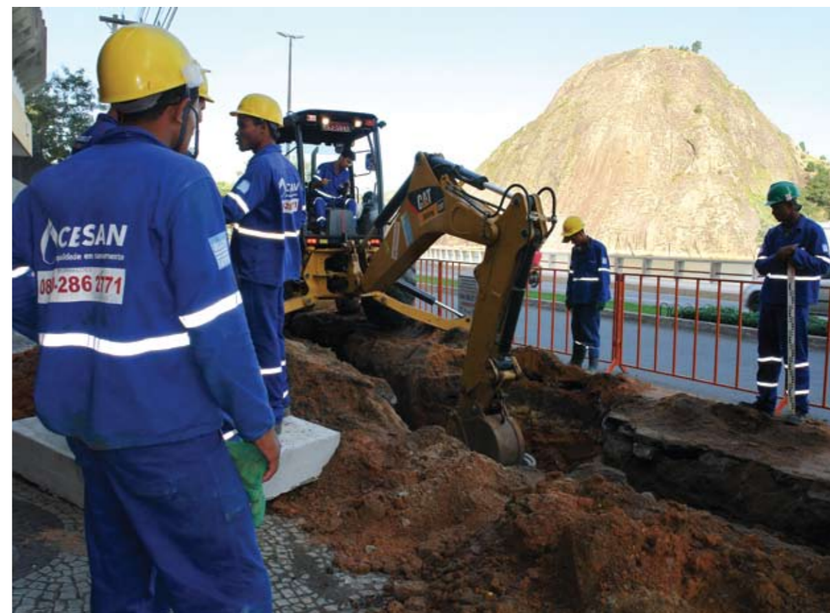
Obra de esgotamento sanitário em Vitória
