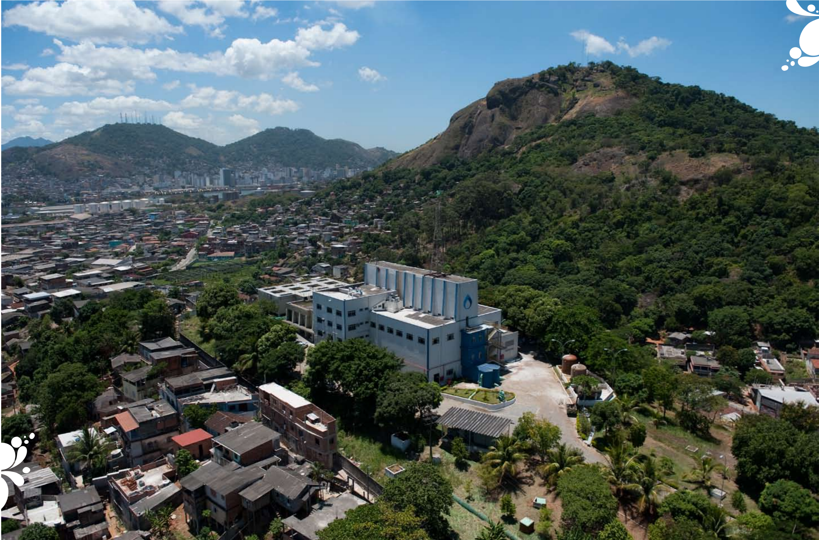
Estação de Tratamento de Água Cobi, em Vila Velha
