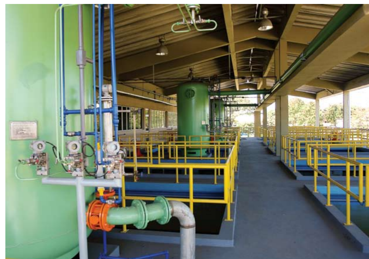
Estação de Tratamento de Água Carapina, na Serra
