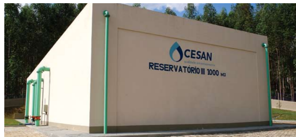
Reservatório de água em Nova Venécia
