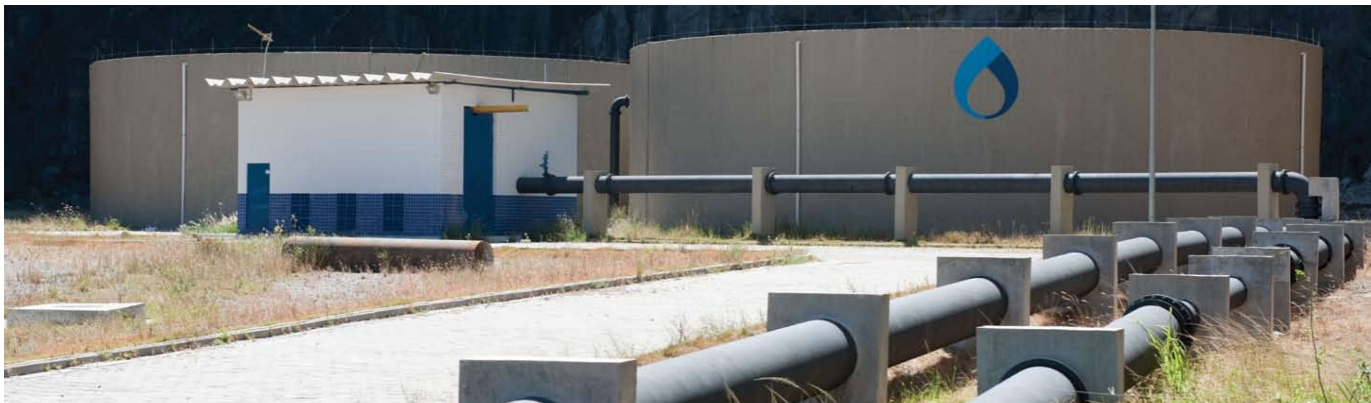
Reservatório de água Pedreiras, em Vitória, com capacidade para 4 milhões de litros
