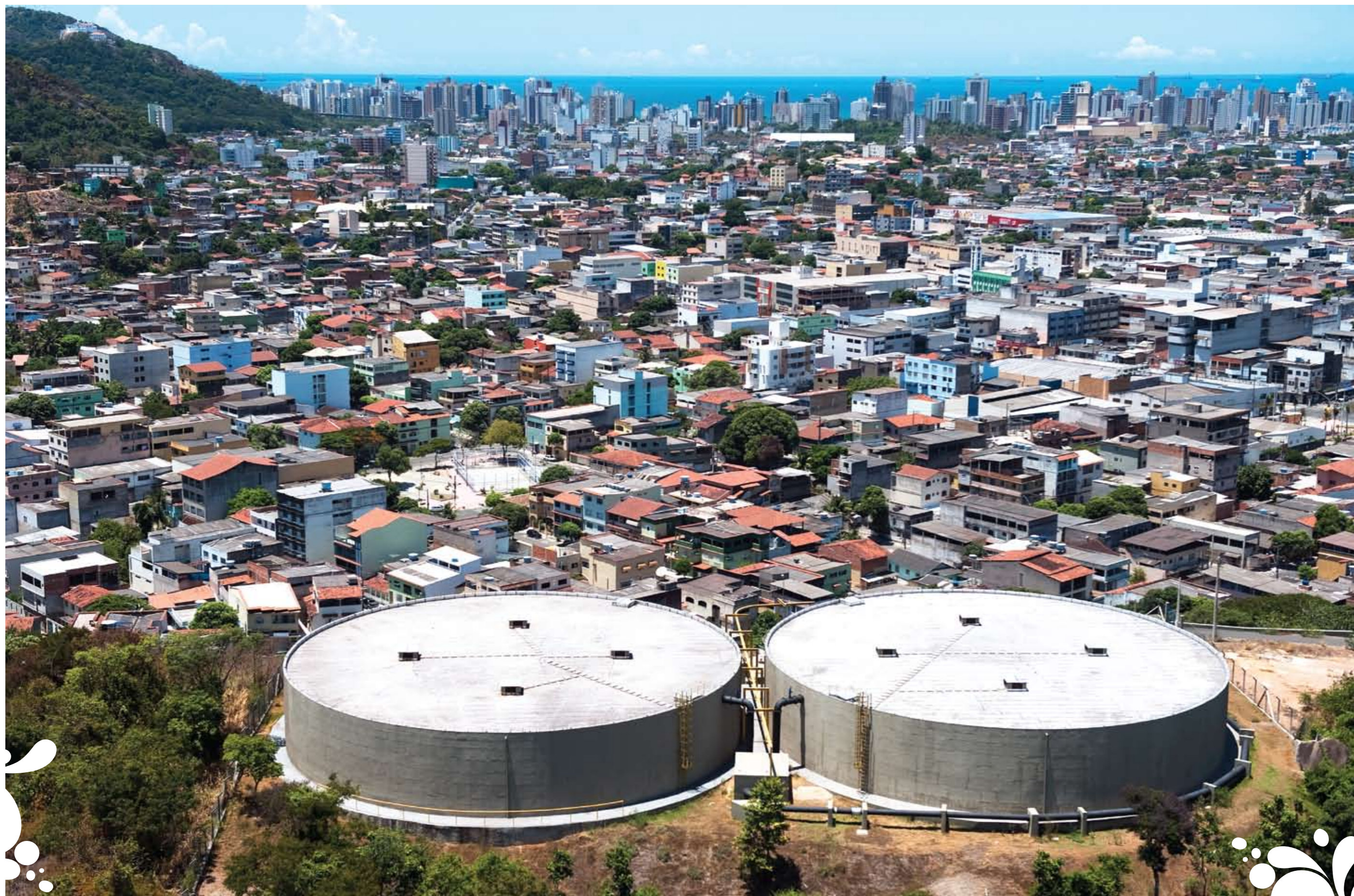
Reservatório de Água Garoto, em Vila Velha, com capacidade para 10 milhões de litros
