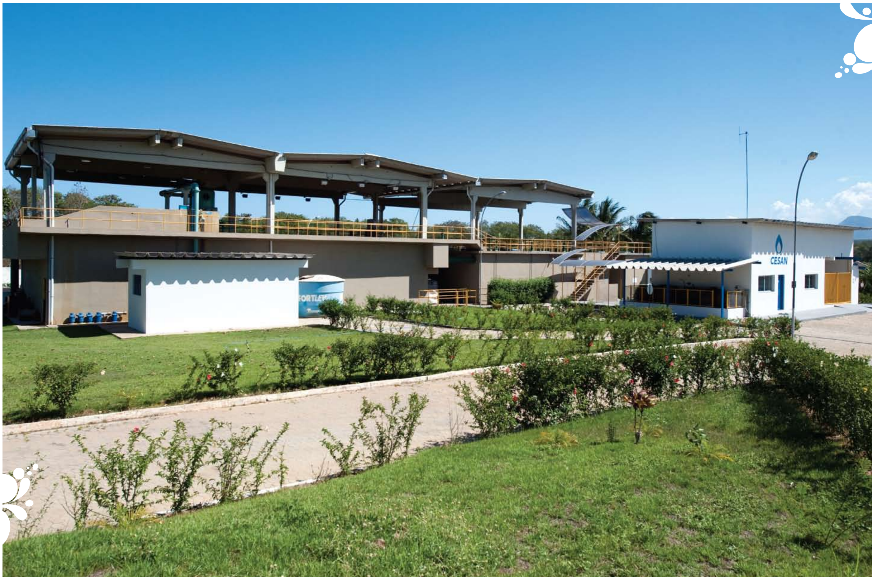
Estação de Tratamento de Água Santa Maria, na Serra
