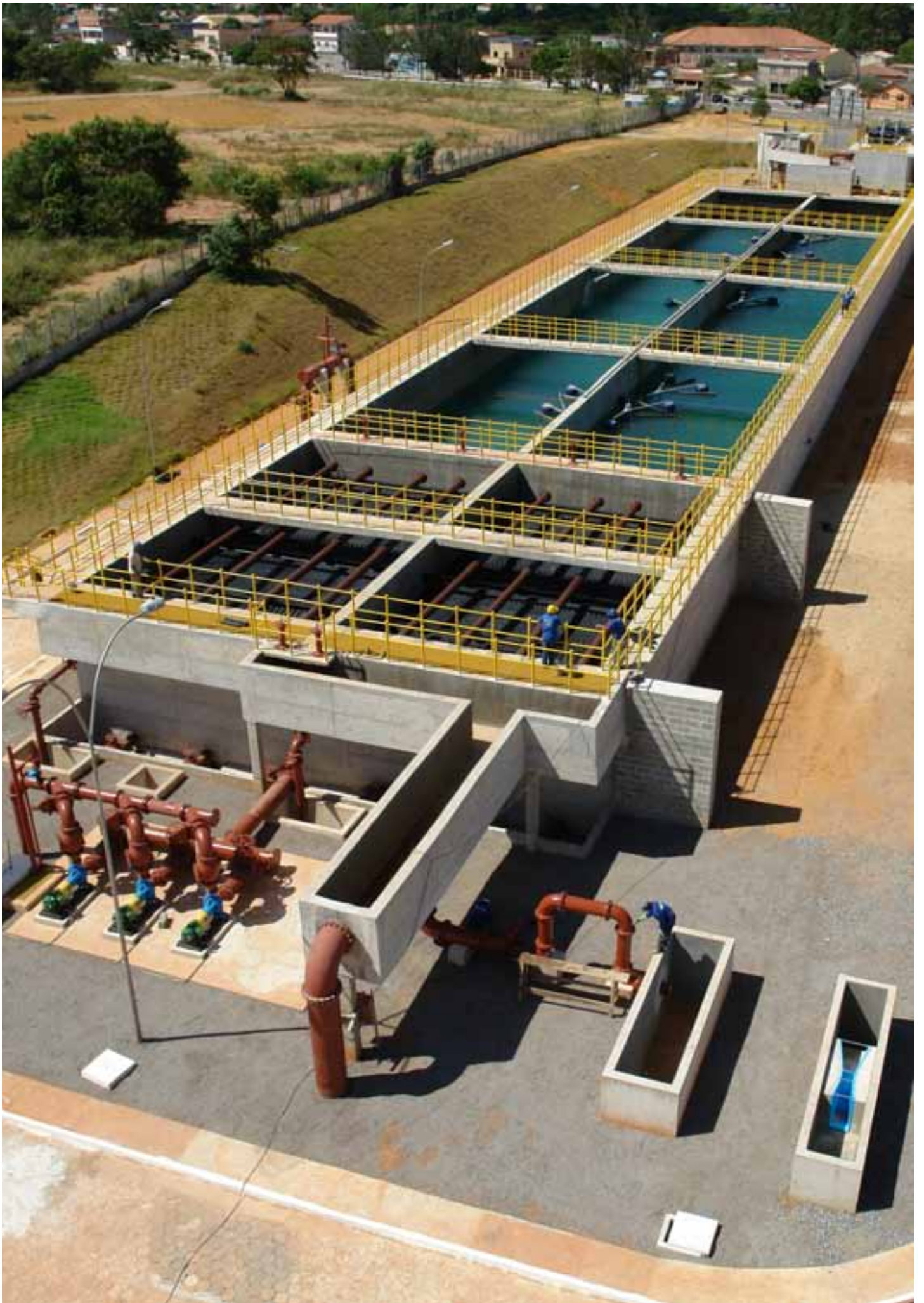
Estação de Tratamento de Esgoto Mangueiros
