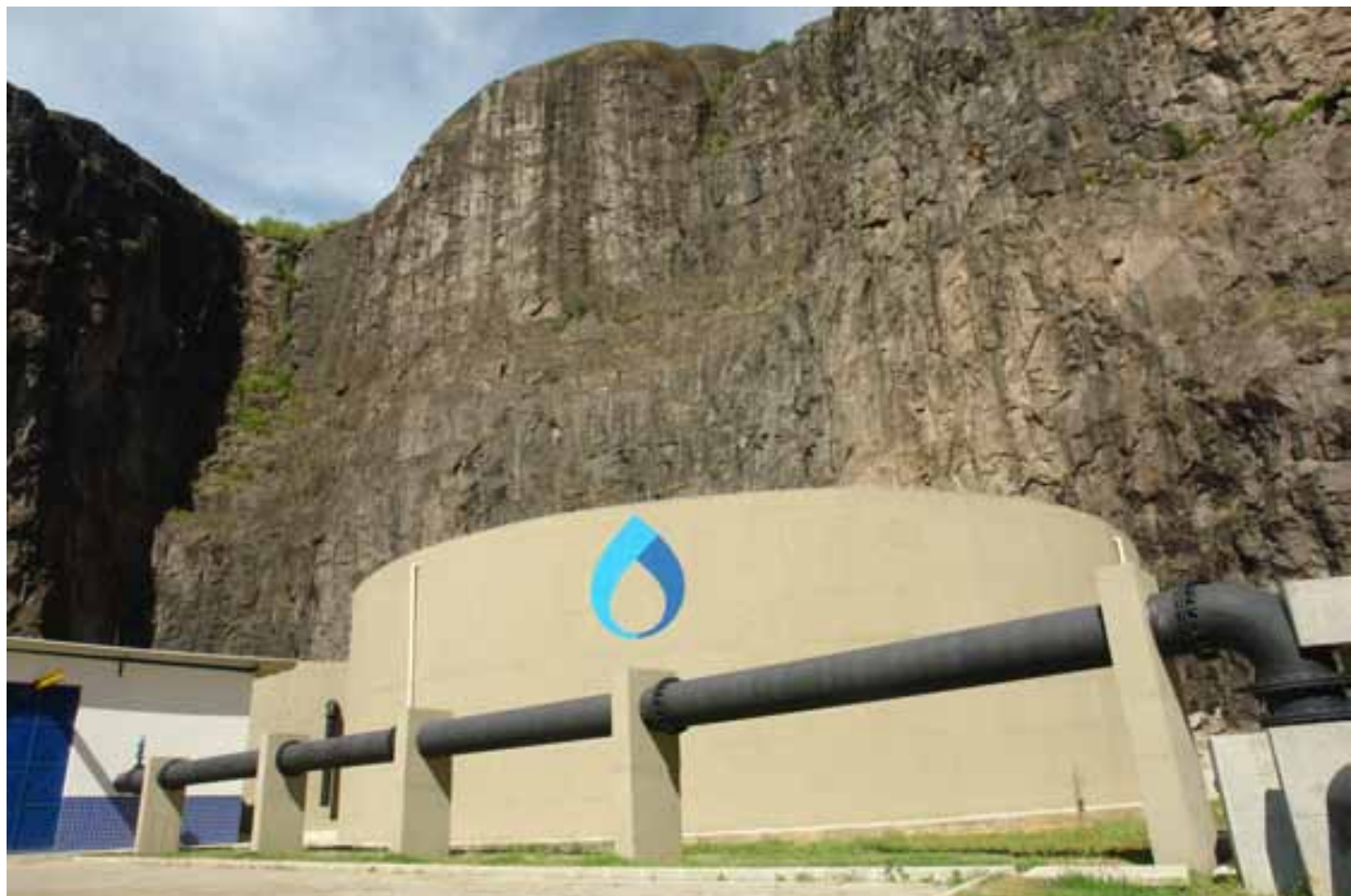
Reservatório de água Pedreiras
