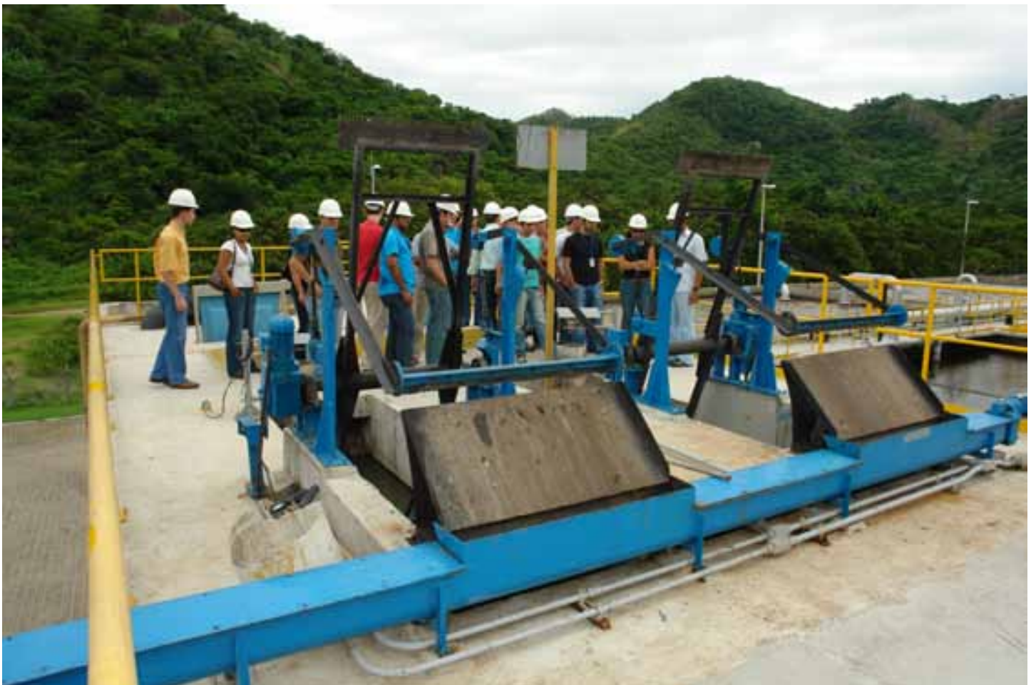
Novos empregados em visita à Estação de Tratamento de Esgoto Mulembá, em Vitória
