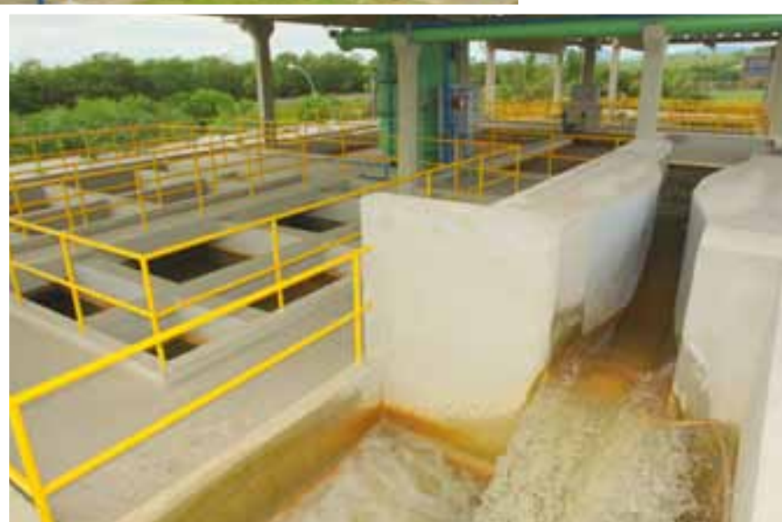
Melhoria da Estação de Tratamento de Água Santa Maria
