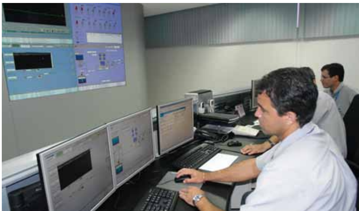
Centro de Controle Operacional, em Carapina
