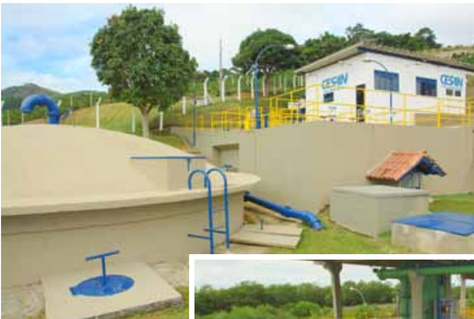
Ampliação da Estação de Tratamento de Água de Venda Nova do Imigrante
