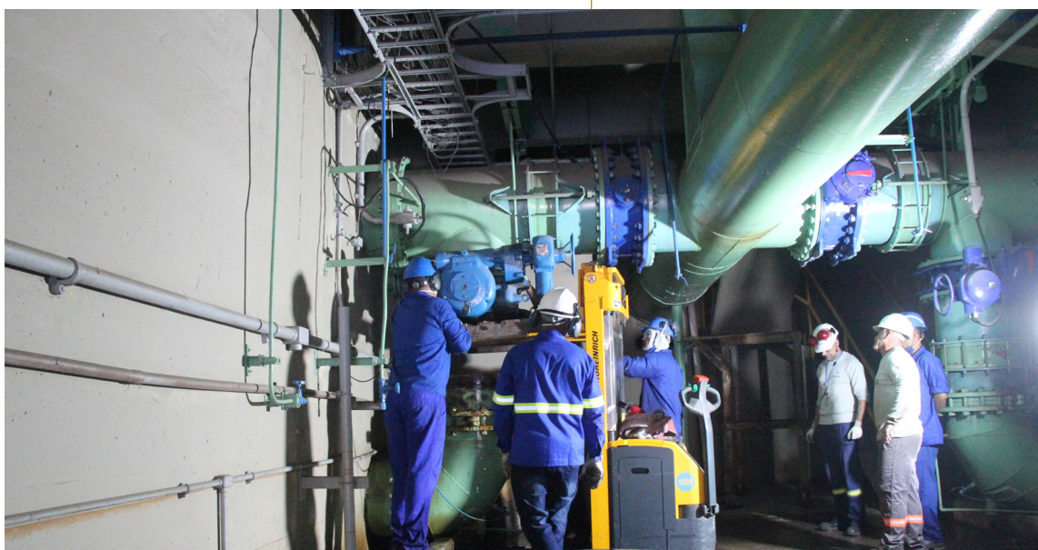
Obras na Estação de Tratamento de Água (ETA V), no município de Serra
