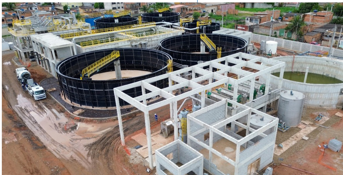
Obras na Estação de Tratamento de Esgoto (ETE) de Ulisses Guimarães (Vila Velha)
